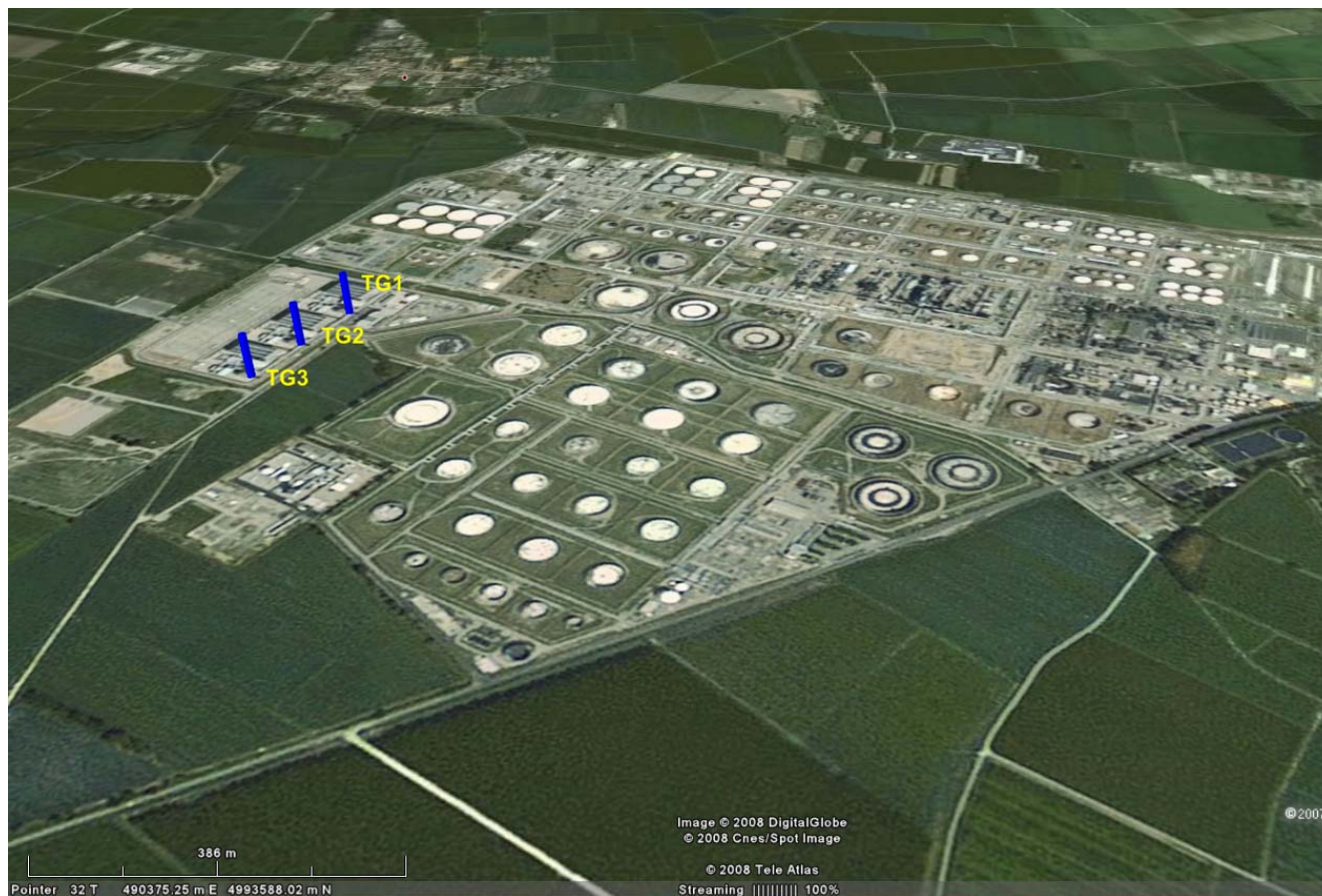
Figura 3.1. Posizione delle sorgenti della Centrale EniPower considerata nello studio.
