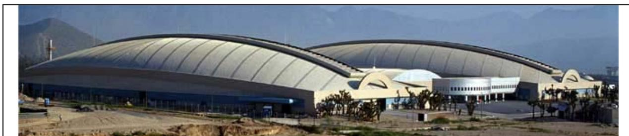
Per garantire la ventilazione dell'edificio sono previste apposite aperture lungo l'asse longitudinale della copertura a volta; inoltre, gli opportuni sistemi di filtrazione e di aspirazione garantiranno il contenimento delle polveri generate dalle operazioni di deposito e di ripresa dal cumulo di carbone.
