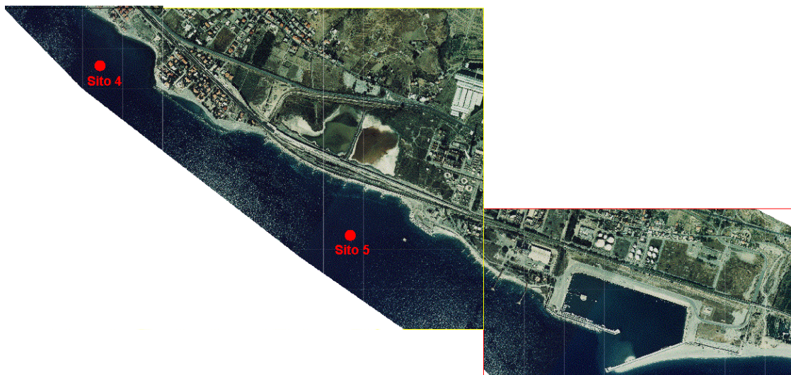
Figura 1 – Localizzazione su ortofoto dei siti di estrazione del clima ondoso sottocosta – dettaglio 1.
