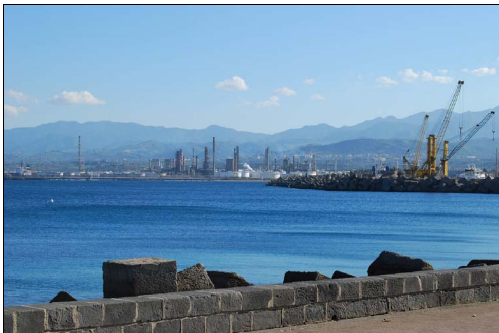
Figura 6-2: Inserimento paesaggistico Raffineria di Milazzo (configurazione futura) (da Ovest-NordOvest)
