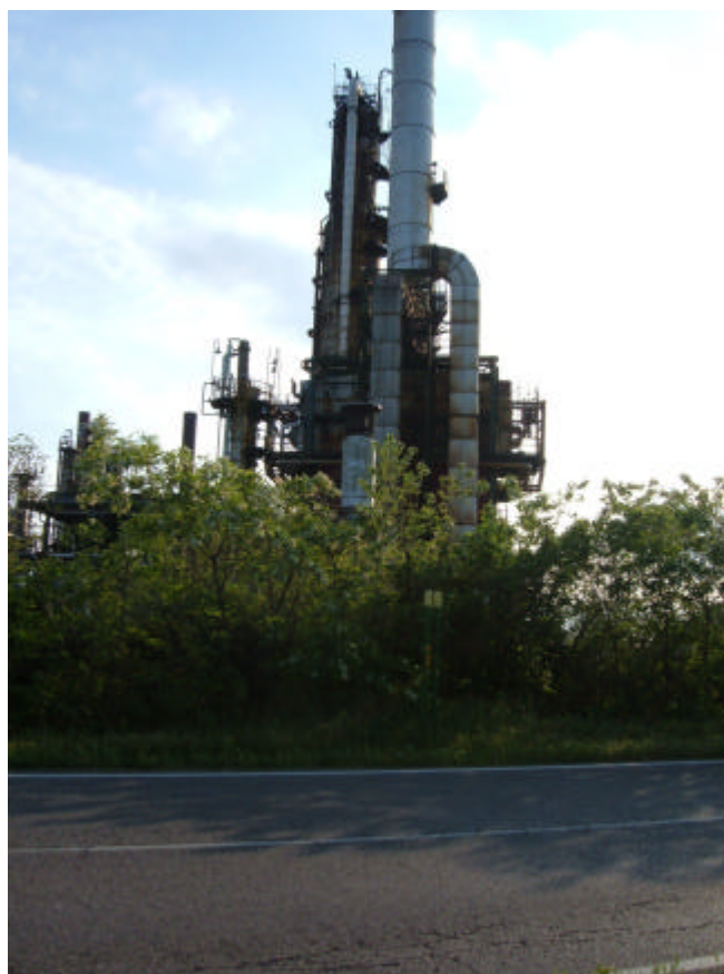
Da R4 verso la raffineria.
