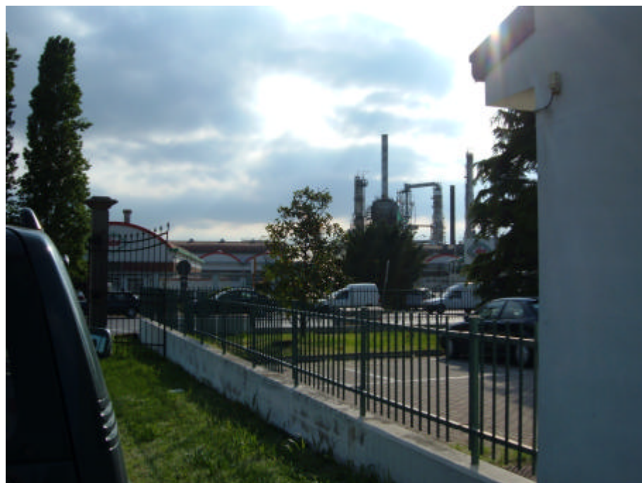
Da R2 verso la raffineria
