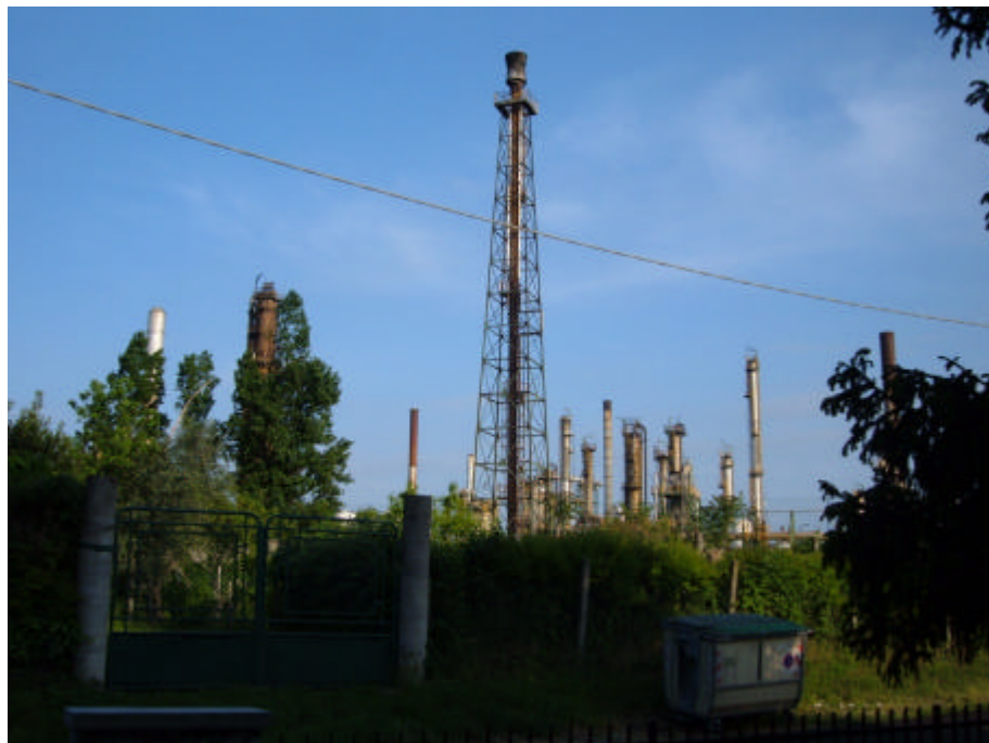
Da R5 verso la raffineria
