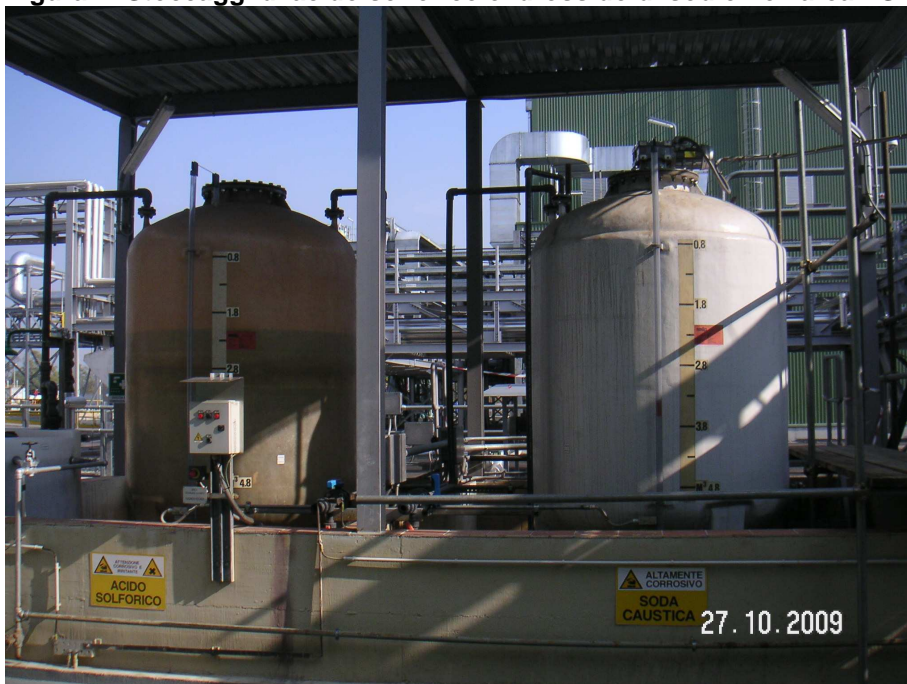
Figura 2: Stoccaggi di acido solforico e idrossido di sodio nell'area AS4
