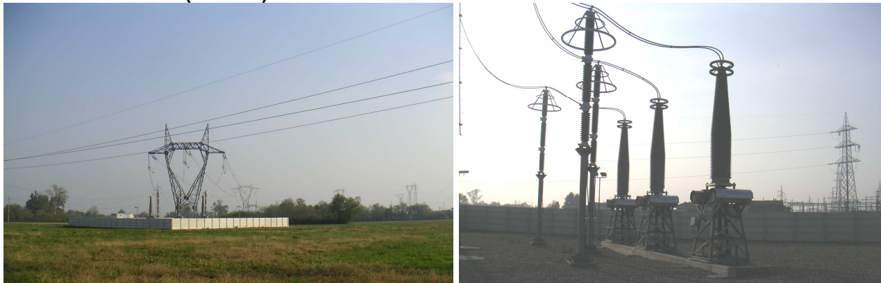
Figura 7 – Ultimo sostegno del tratto aereo dell'elettrodotto (a sinistra) e particolare dell'interramento della terna di cavi (a destra)
