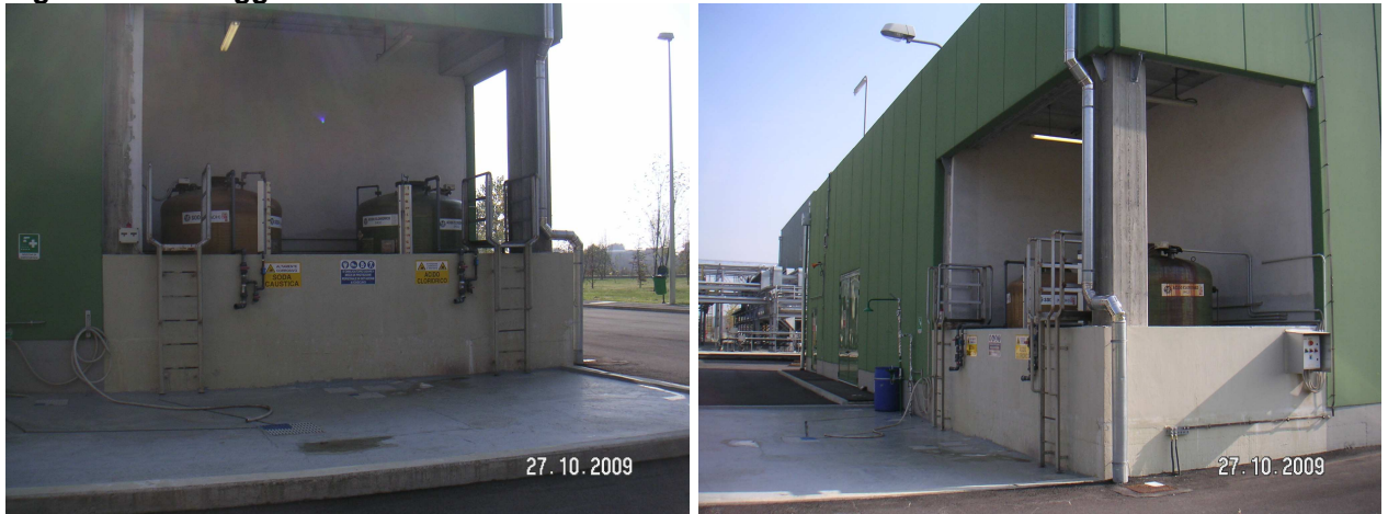
Figura 2: Stoccaggi di acido solforico e idrossido di sodio nell'area AS4
