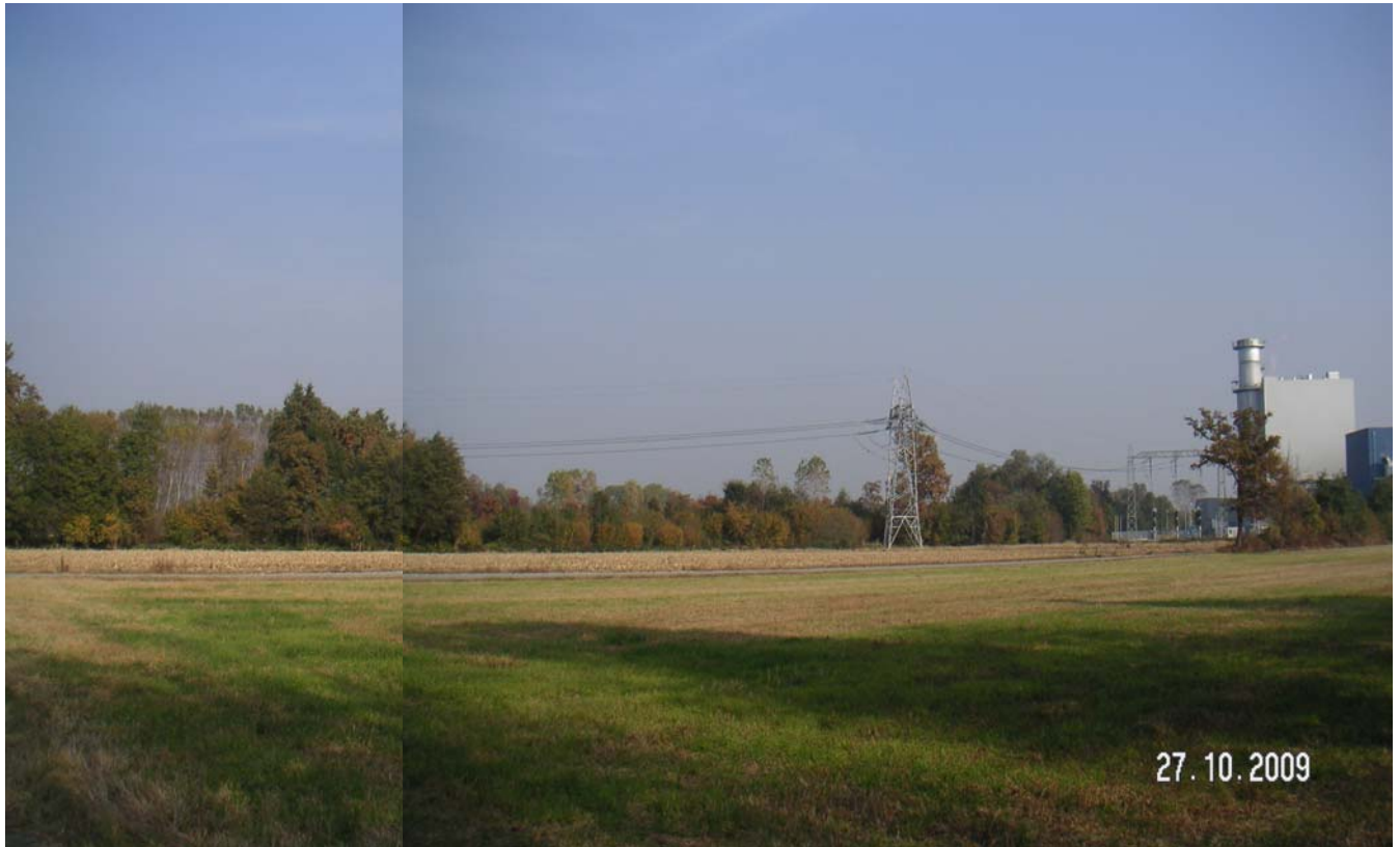
Figura 3 – Sostegno PV1 e stazione elettrica di uscita dalla Centrale
