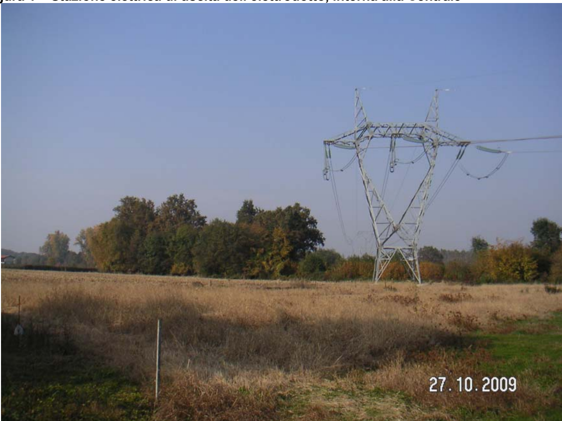
Figura 2 – Sostegno PV1, vista da sud
