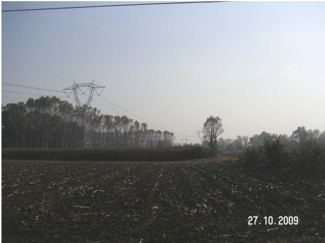
Figura 6 – Da sinistra a destra, sostegno PV4 e in lontananza sostegni PV3 e PV2
