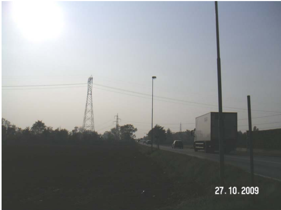
Figura 12 – Sostegno PV10 e strada intercomunale Leini – Volpino
