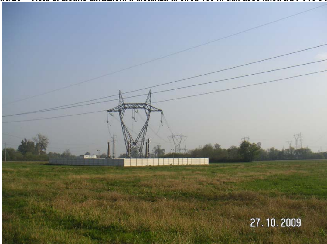
Figura 21 – Ultimo sostegno PV19 all'interno di area recintata. Sul retro si vede il sostegno PV18
