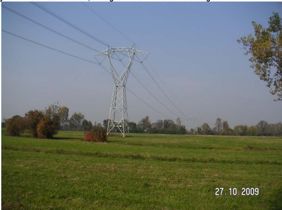
Figura 7 – Da sinistra a destra, sostegno PV5 e in lontananza sostegno PV6
