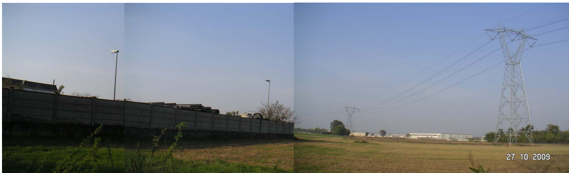
Figura 8 – Da destra a sinistra, sostegni PV8 e PV9. Sulla sinistra vi è un insediamento industriale lontano circa 110 m dall'asse linea
