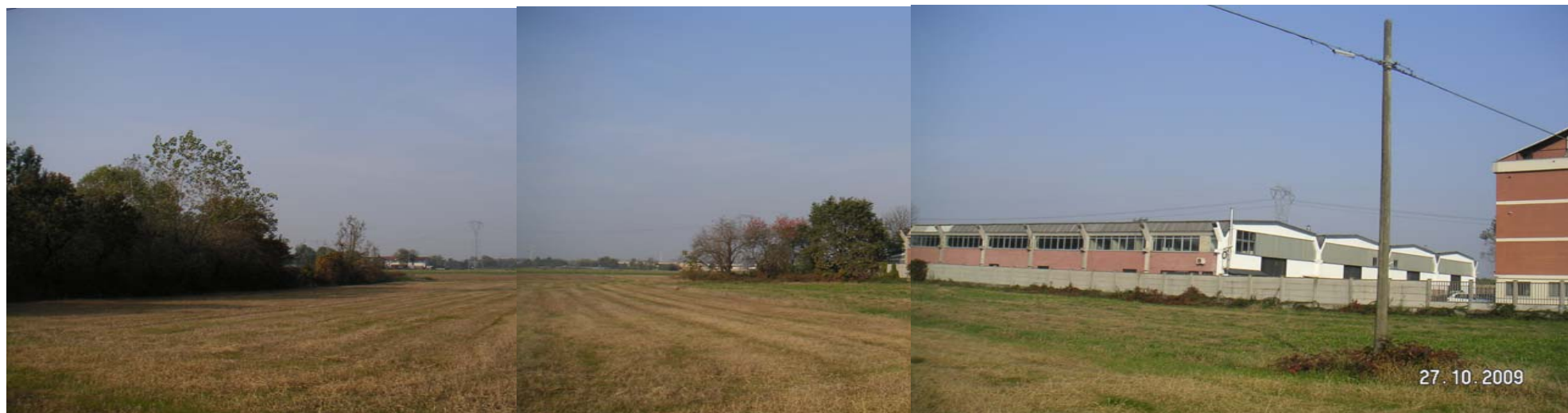
Figura 9 – A sinistra dietro i magazzini vi è il sostegno PV8, mentre sull'orizzonte vi è il sostegno PV9
