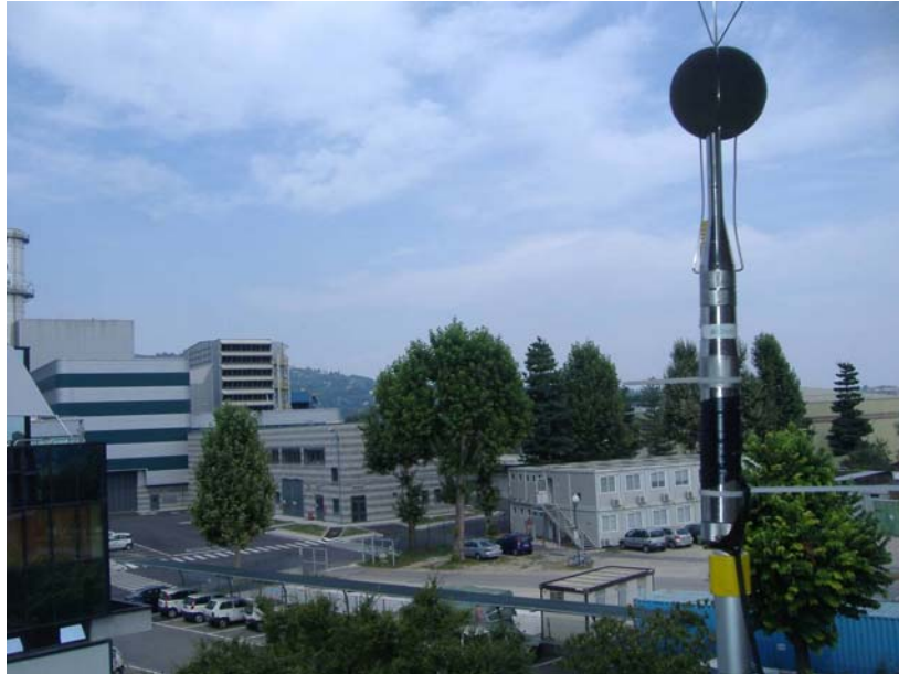
Gli impianti della centrale visti dal punto di misura in esterno presso CASE AEM (II piano)
