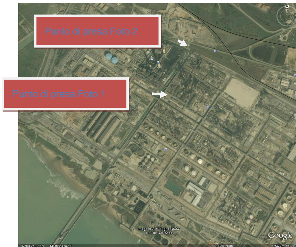
Figura 16.1: Aree riprese in foto 1 e in foto 2 dell'Allegato 9 alla Valutazione di incidenza.
