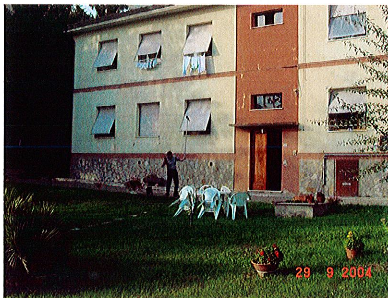
Punto 6 :Rilievo fronte abitaz. N°15, località Montanina
