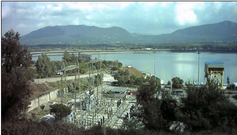
Fig. 7.2.1.1 La sottostazione di Presenzano
