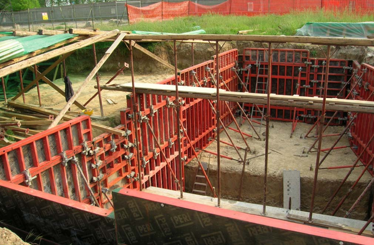
Zona XII – Porzione dello scavo con pareti messe in sicurezza mediante cassetta
