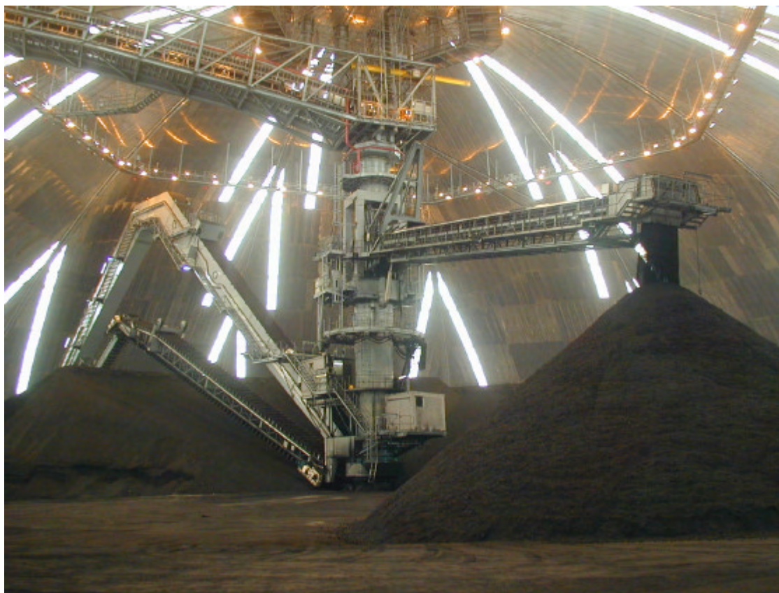
Figura 10: Tipico di macchina di carico e scarico (stacker/reclaimer)
