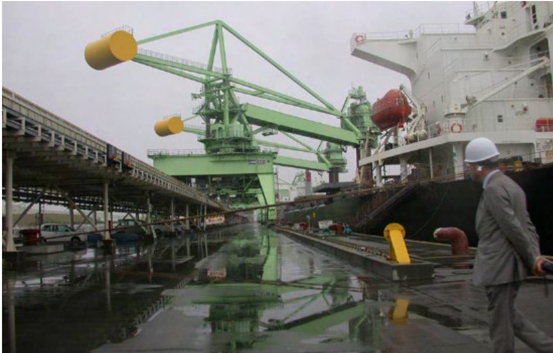
Figura 7: Esempio di scaricatori continui e nastro trasportatore di banchina
