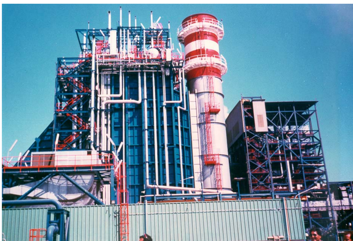
Figura 3: Tipica caldaia a recupero orizzontale a 3 livelli
