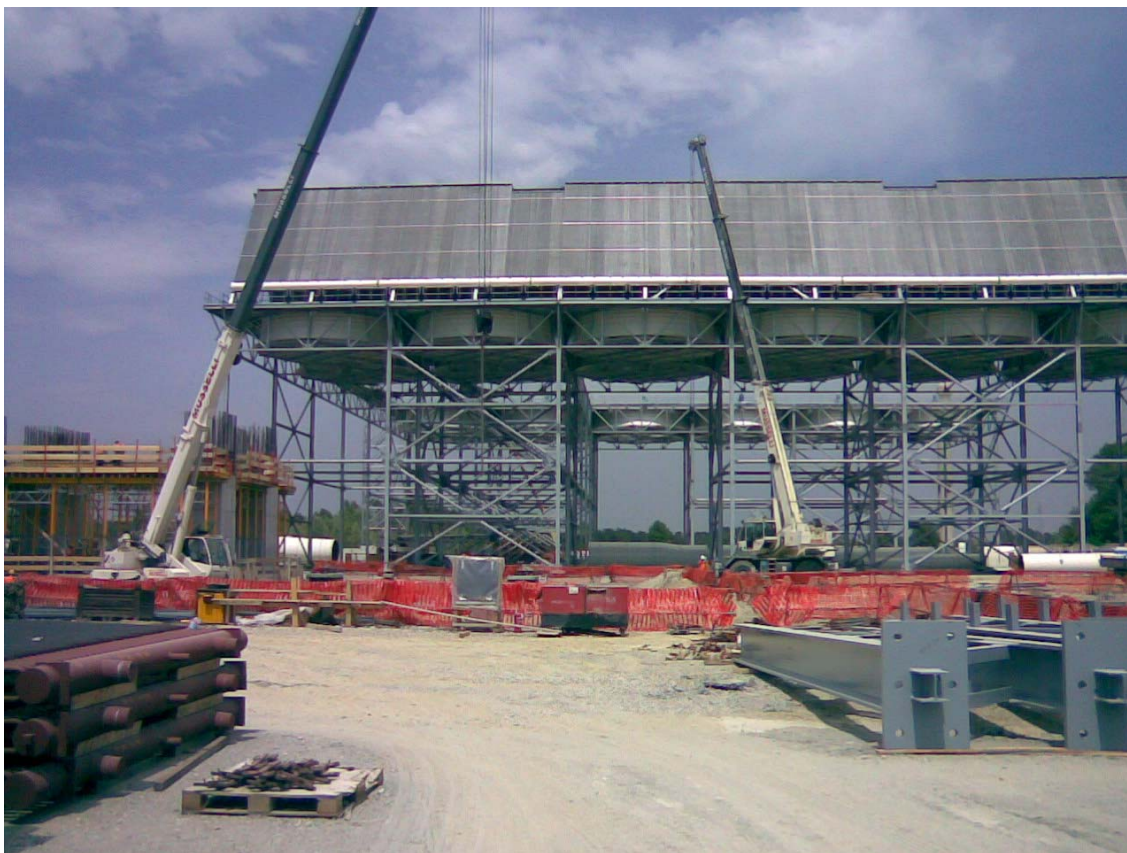
Figura 4: Condensatore ad aria
