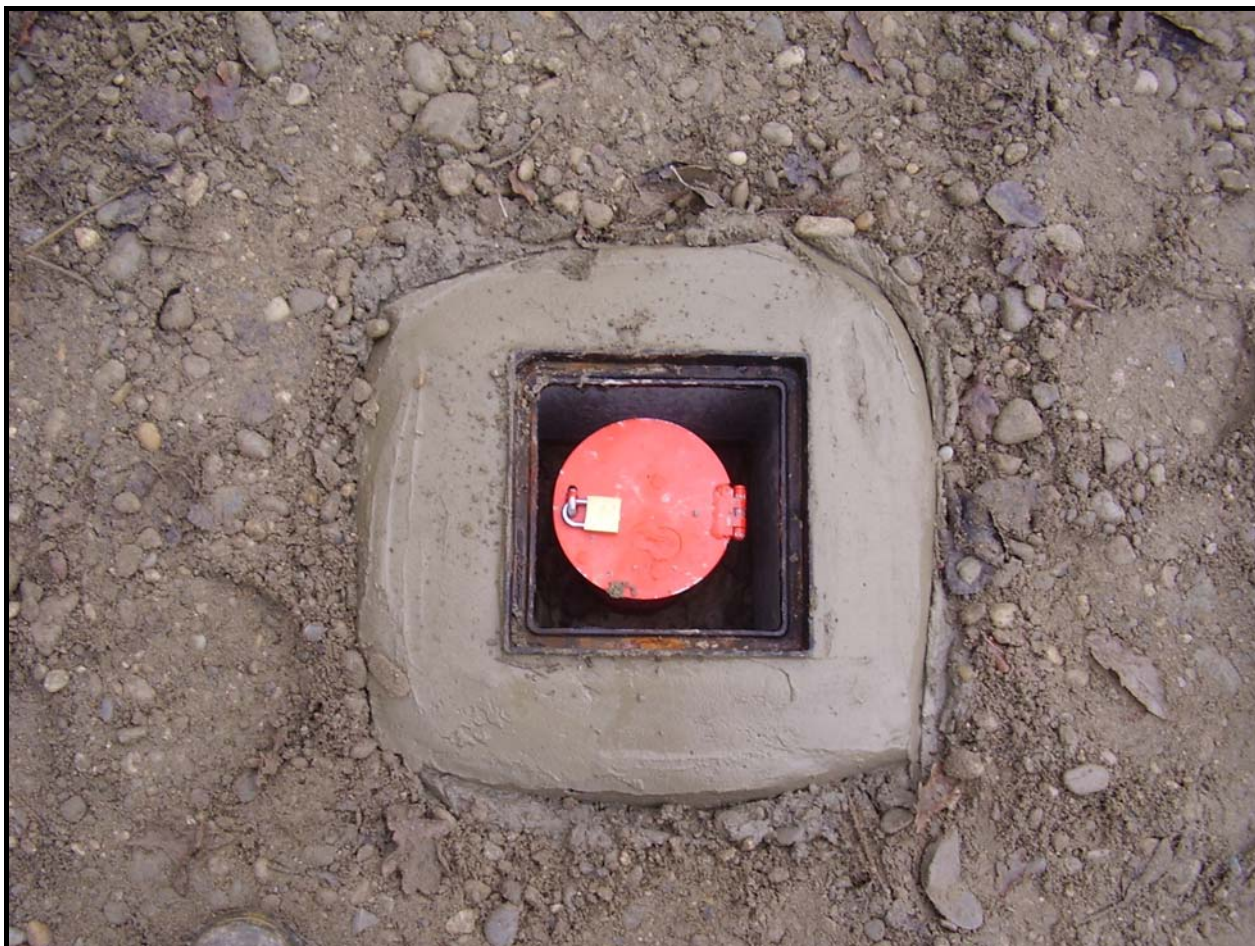
Foto 5: Particolare del tombino provvisto di chiusura con lucchetto
