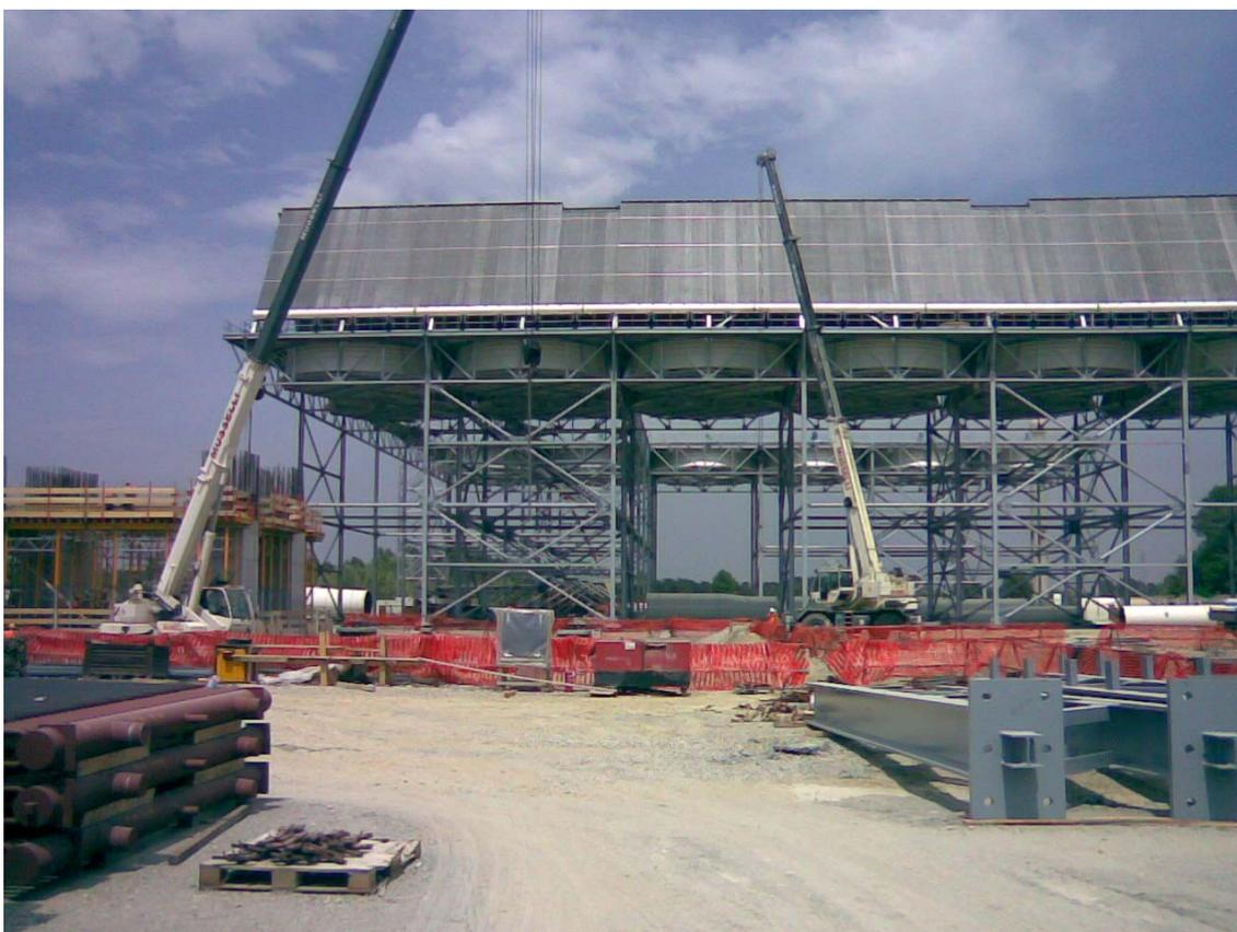
**Figura 5:** Condensatore ad aria
