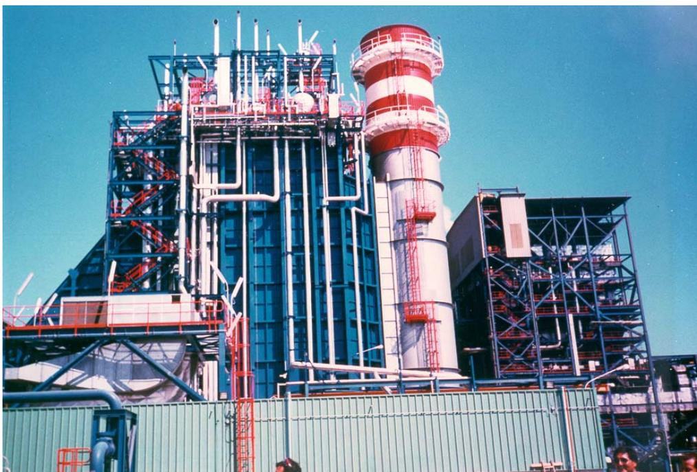
**Figura 3:** Tipica caldaia a recupero orizzontale a 3 livelli
