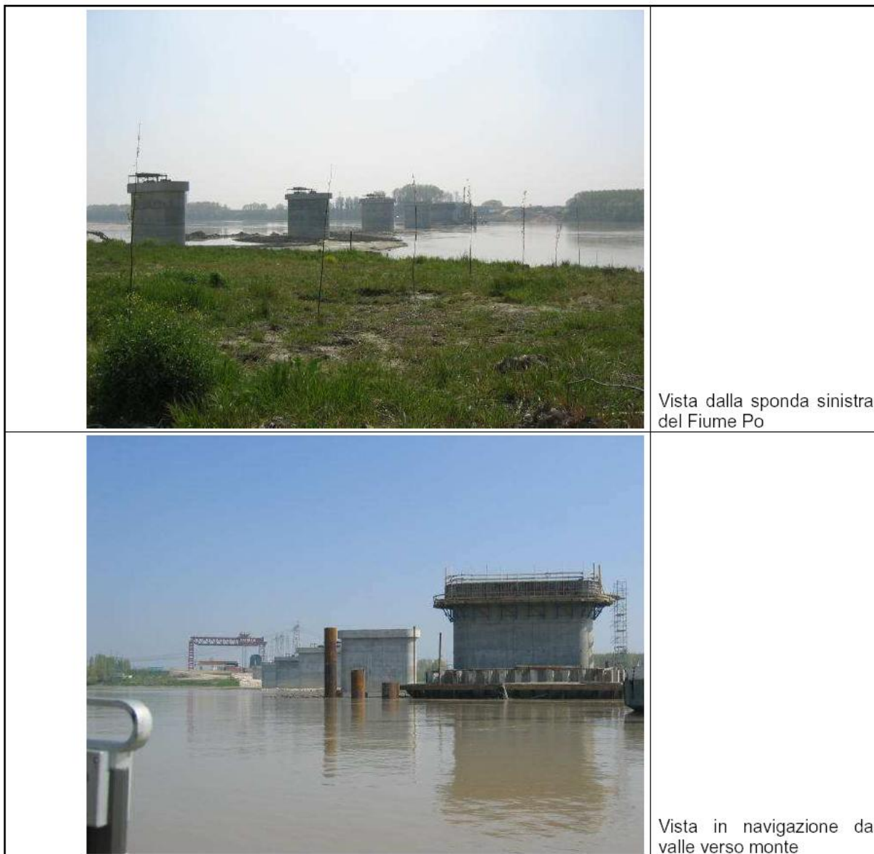
Figura 7 – Ponte ferroviario per il raddoppio della linea Bologna - Verona
