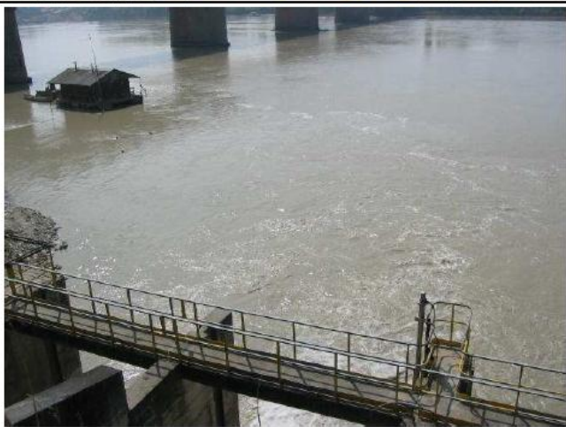
Vista dall'alto dell'opera verso le pile del ponte stradale e ferroviario
