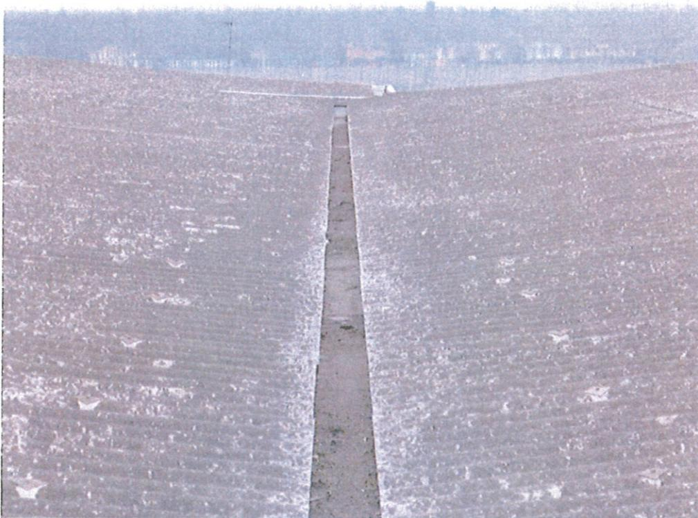
**Foto 11: zona E – panoramica della copertura in cemento amianto dei capannoni stoccaggio melamina e urea**
