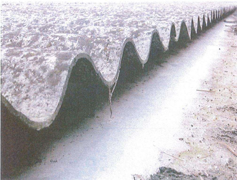
**Foto 16: zona F – canale di gronda e stalattiti del magazzino materie prime**
