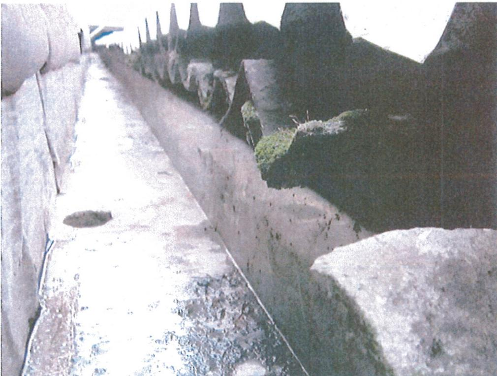
**Foto 6: zona B – confinamento laterale e canale di gronda**
