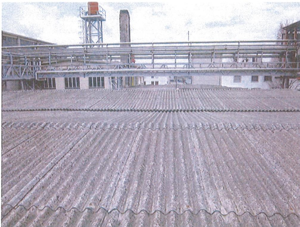
**Foto 1: zona A – panoramica delle coperture in cemento amianto**
