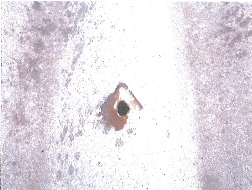
**Foto 10: zona D – particolare della superficie delle lastre e del fissaggio mancante**
