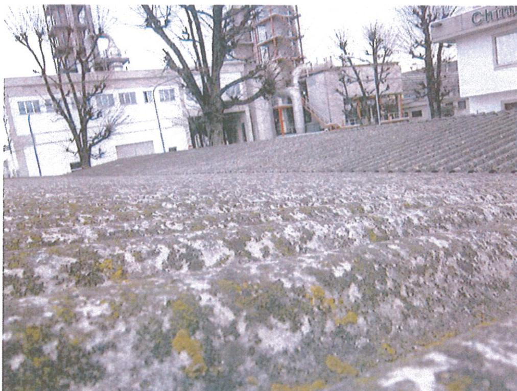
**Foto 8: zona C - panoramica della tettoia corta in cemento amianto del parcheggio uffici**
