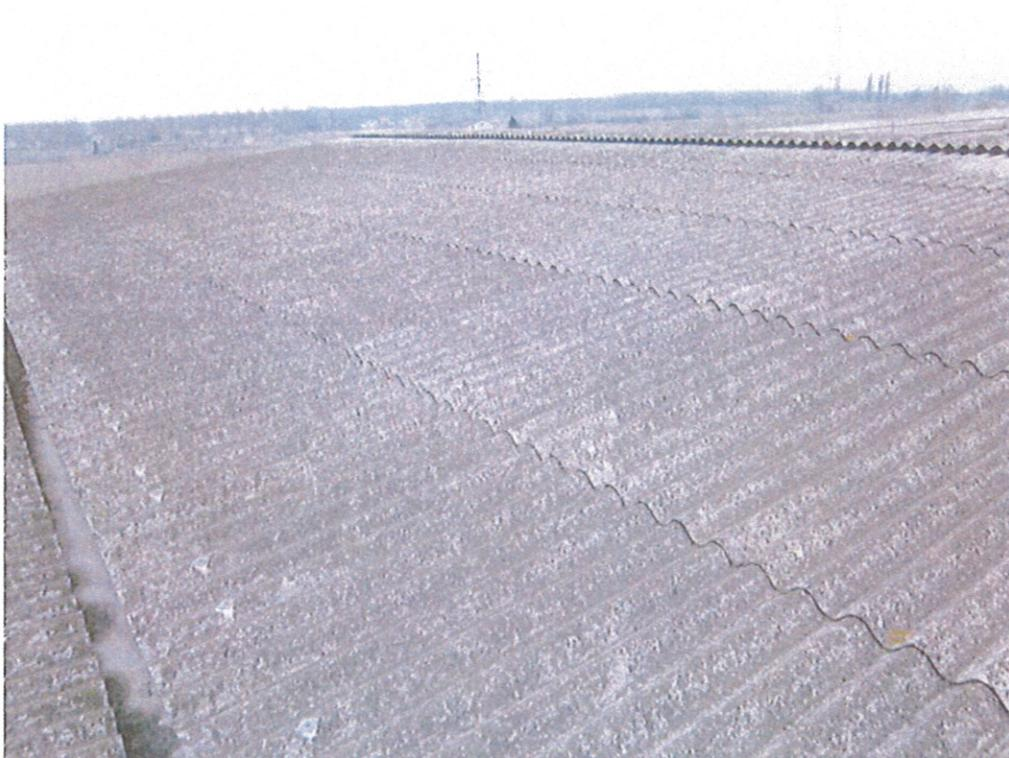
**Foto 15: zona F - panoramica della copertura in cemento amianto (magazzino mat. prime)**
