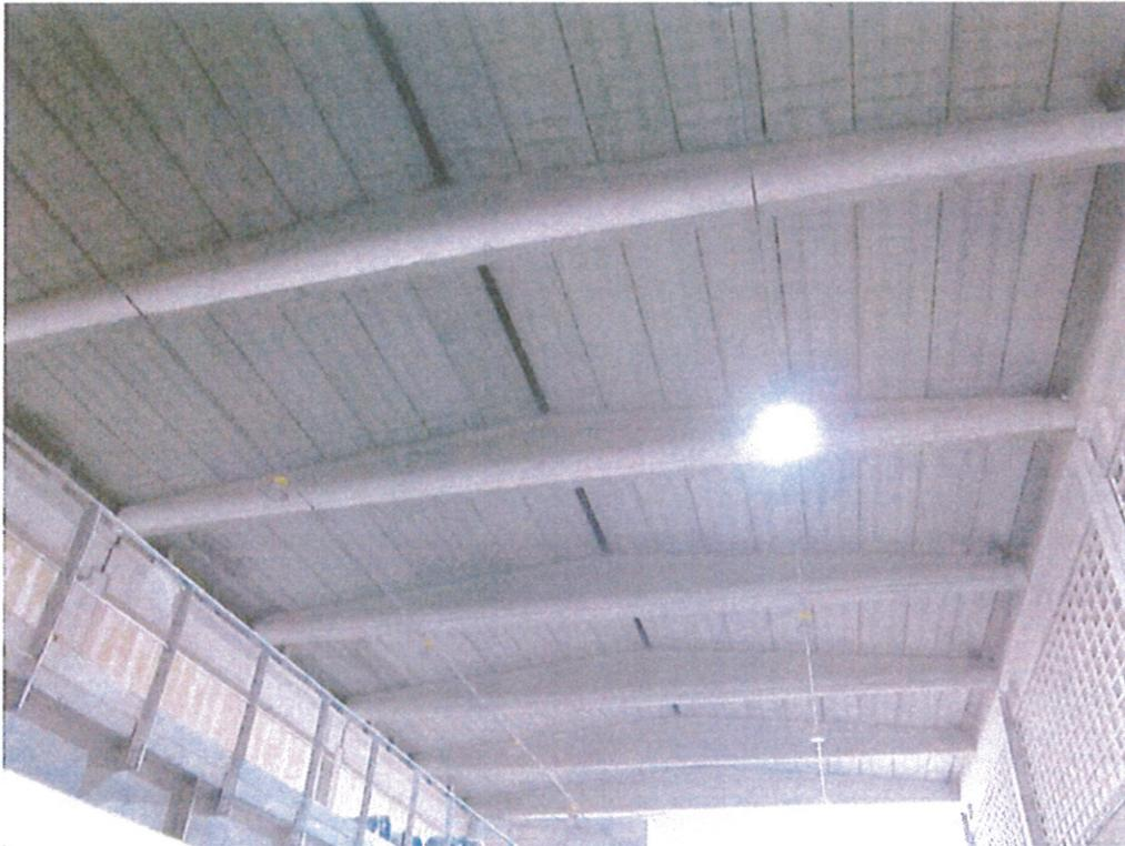
**Foto 17: intradosso con tavelloni in cemento armato del magazzino materie prime**
