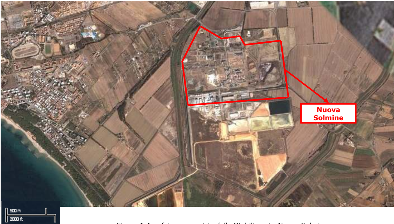
Figura 1 Aerofotogrammetria dello Stabilimento Nuova Solmine
