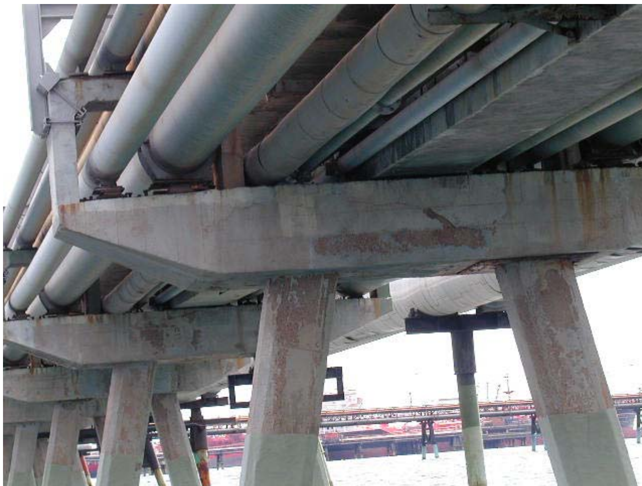
Fig. 6. Pontile principale, (attorno alla campata n° 30). Un appoggio diretto sul pulvino non appare possibile.
