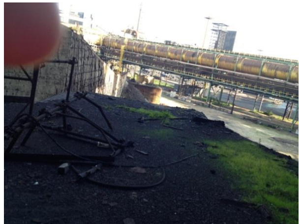
Foto 1: ostacoli ed impedimenti nei camminamenti e mancanza di parapetti e aperture nei piani
