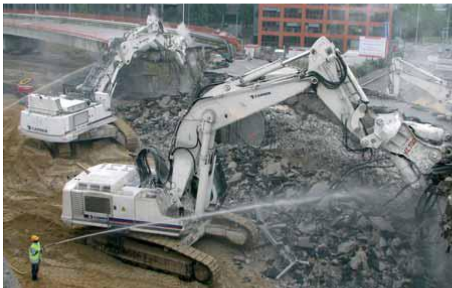
Figura 9: esempio di demolizioni con mezzi meccanici
