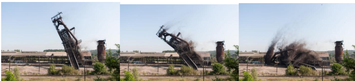
Figura 13 esempio di collasso controllato di altoforno (Clabecq-Belgio-2012)
