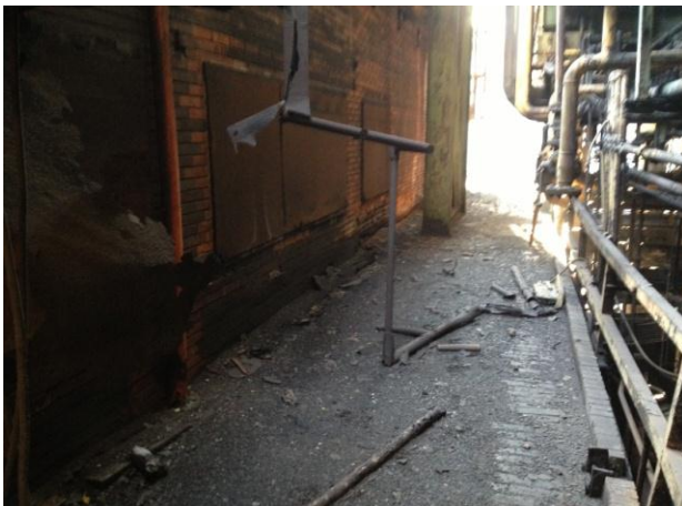
Foto 1: ostacoli ed impedimenti nei camminamenti e mancanza di parapetti e aperture nei piani
