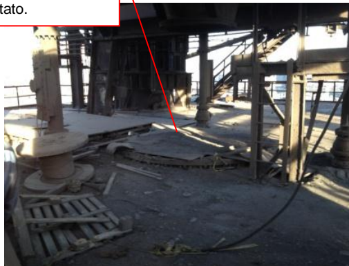
Foto 5: Strato di polvere e materiali accumulati sui piani in quota AFO 3
