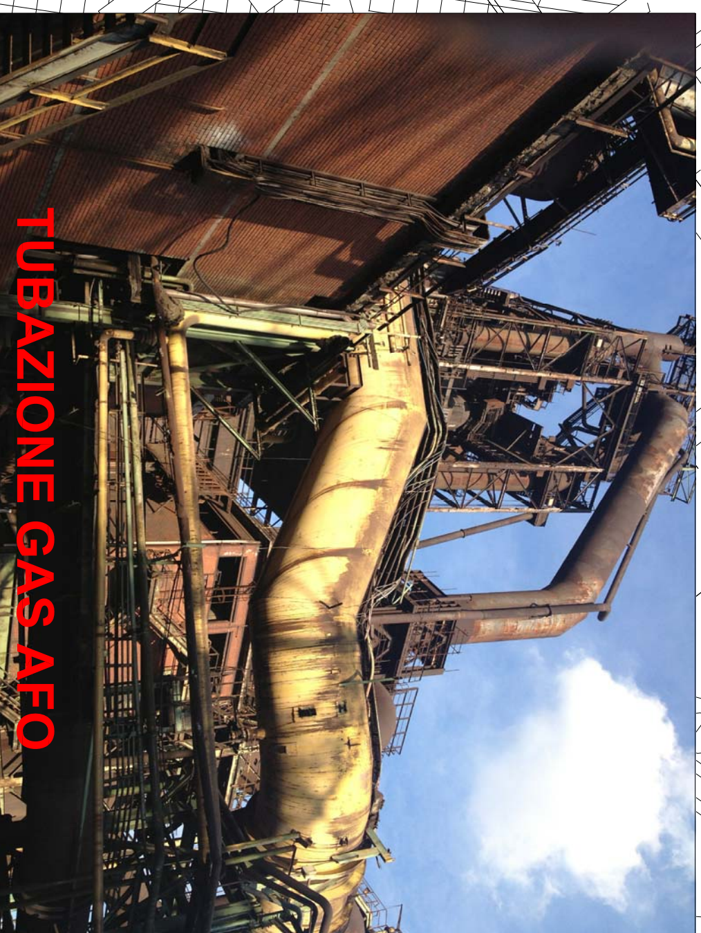
SEZIONAMENTO TUBAZIONE GAS AFO E VENTURI FREDDO
