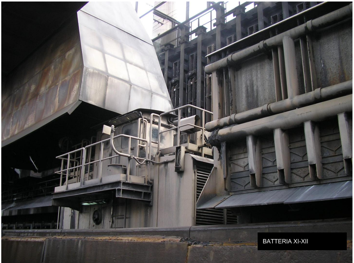
Foto Batterie XI-XII – Operazione di sfornamento
