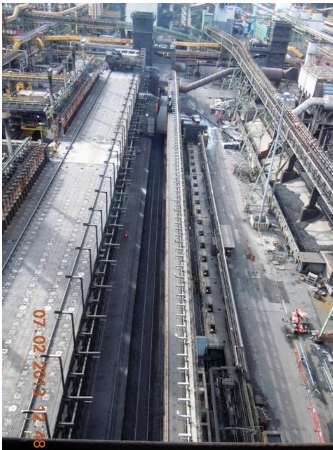
Foto Batterie VII-VIII Vista d'insieme lato coke
