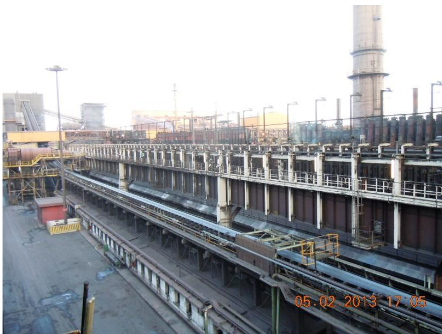
Foto Batterie IX-X Rampa di scarico coke n°5 con nastro sovrastante
