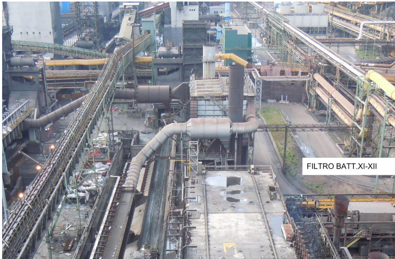
Foto Batterie XI-XII . Gruppo aspiro-filtrante per il trattamento delle emissioni durante lo sfornamento.
