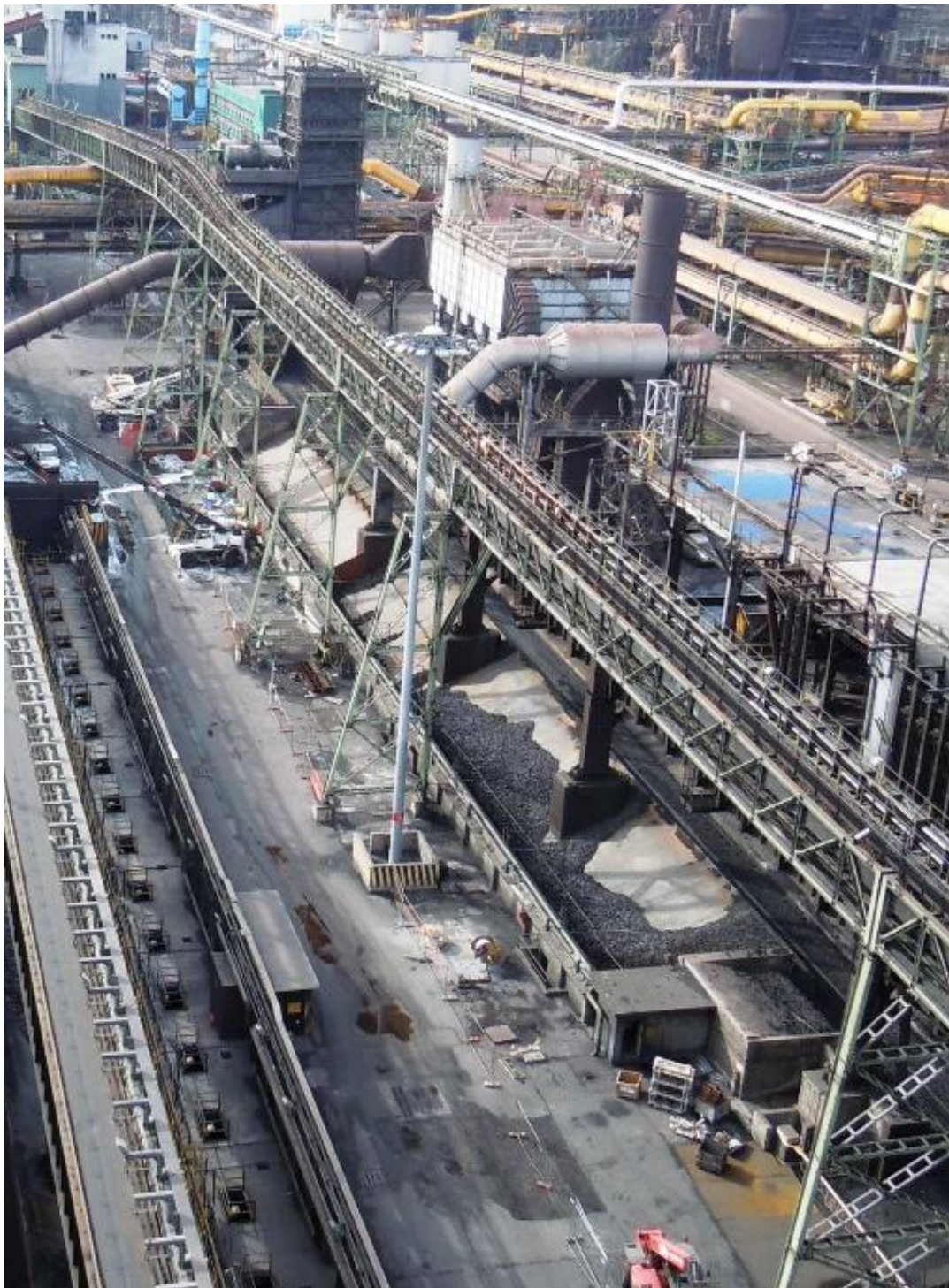
Foto Batteria XI Particolare della rampa di scarico coke n°6
