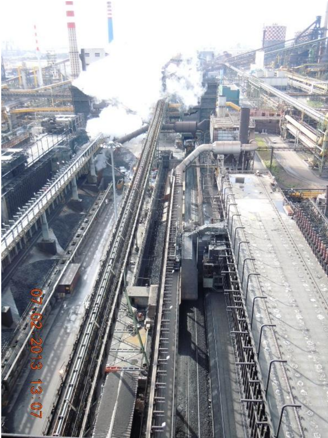
Foto Batteria XI Vista d'insieme lato coke
