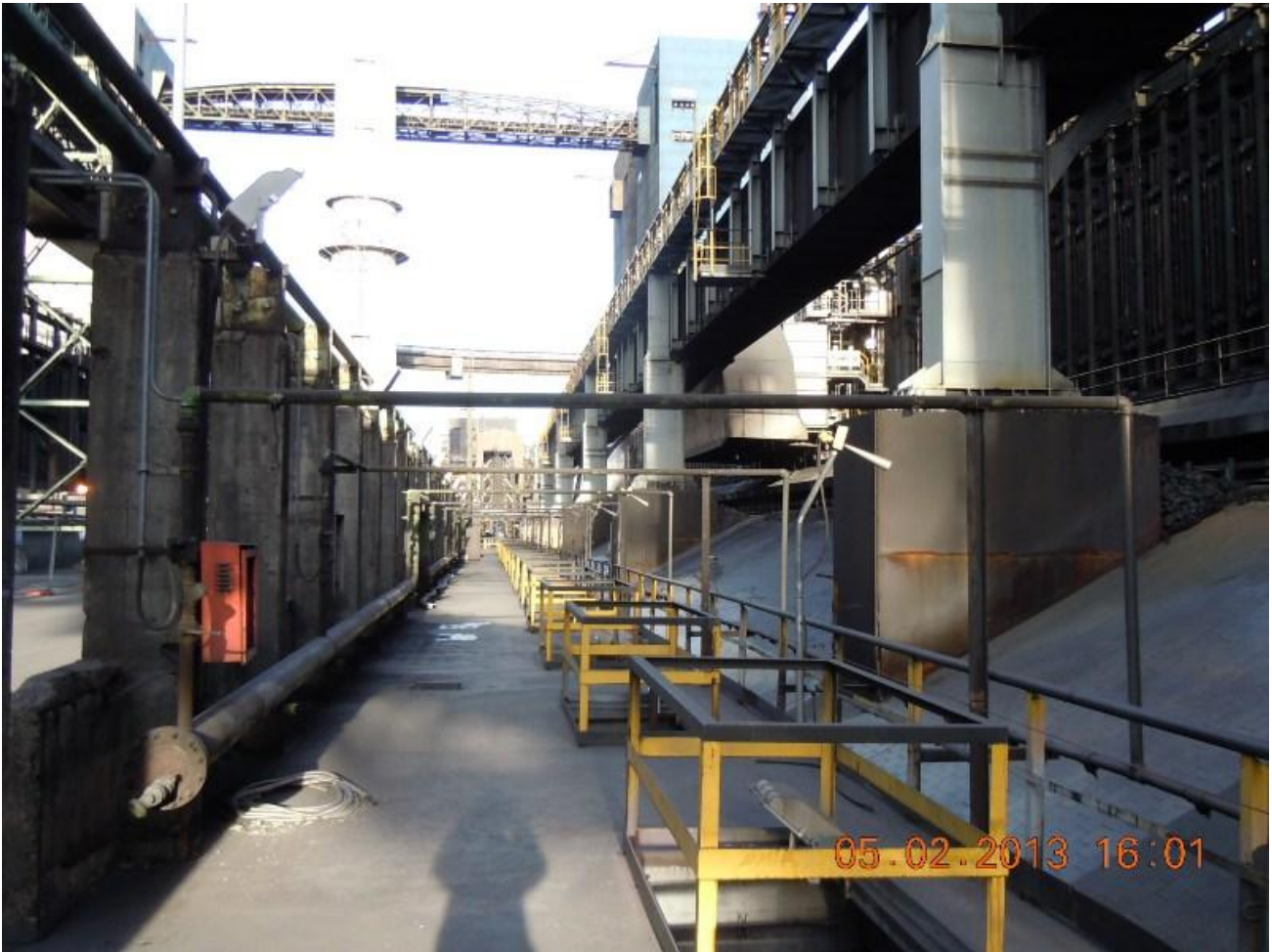
Foto Batterie VII-VIII Particolare della rampa di scarico del coke n°4.
