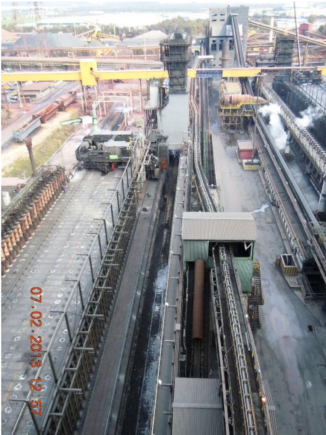
Foto Vista d'insieme della batteria XII lato coke.
