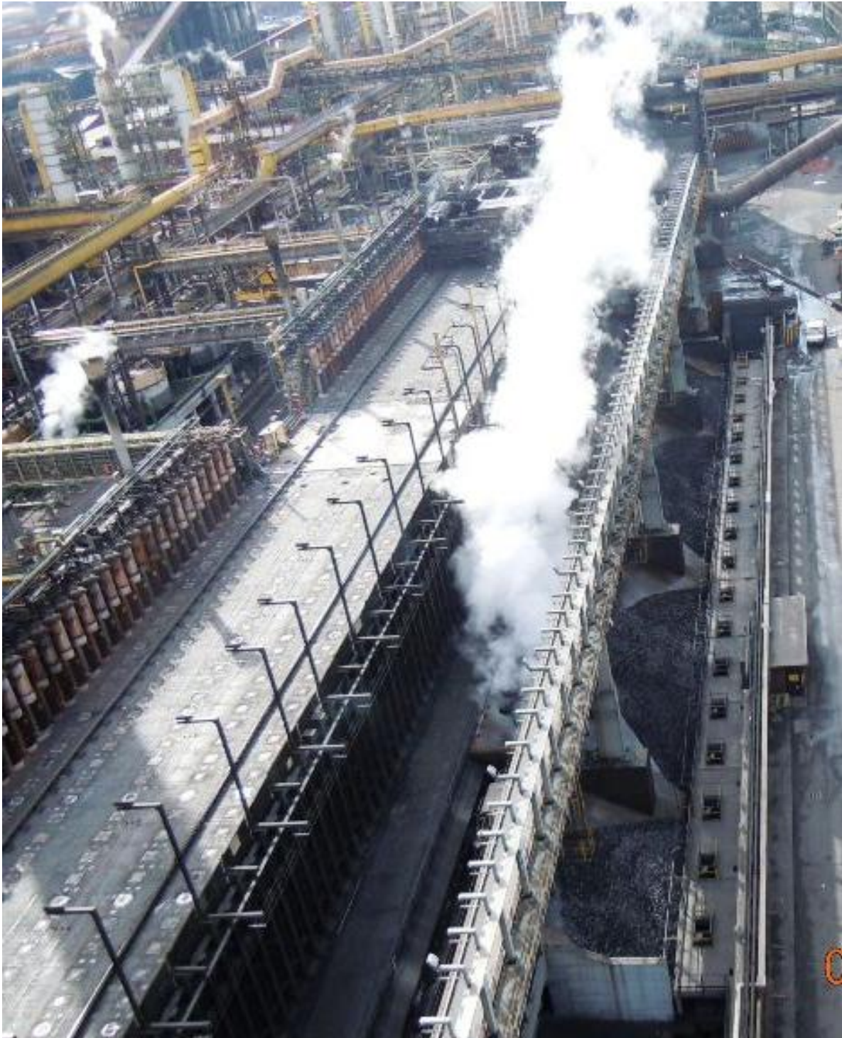
Foto Batterie VII-VIII – Particolare della rampa di scarico del coke n°4
