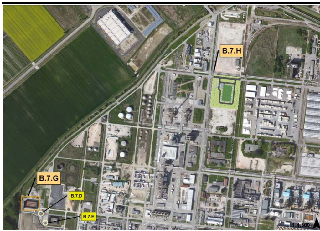
Figura 1.1 Sistema di Torce - Stabilimento di Ferrara a seguito della modifica
