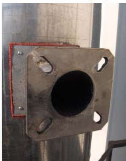
Esempio di tronchetti di prelievo da 4" flangiati
