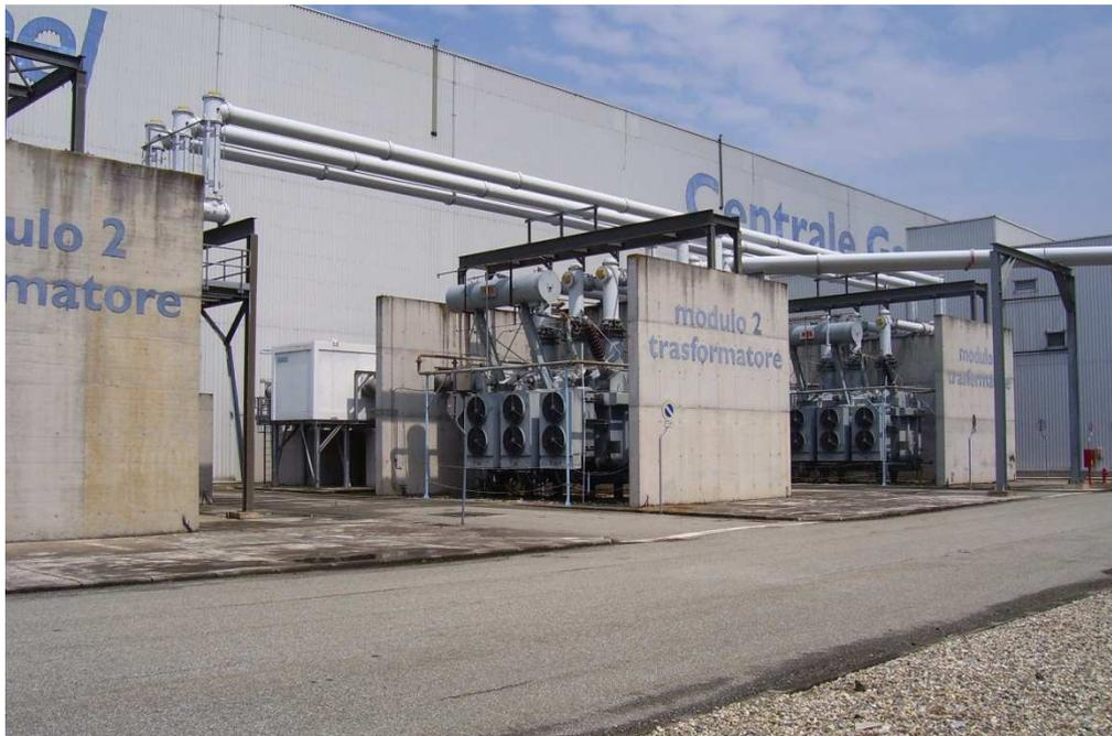
**Figura 3** – Trasformatore di potenza e relativa vasca di contenimento
