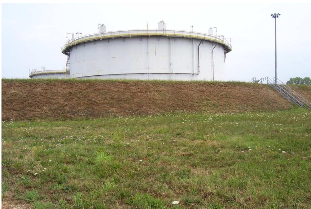
**Figura 4** – Serbatoio di stoccaggio e relativo bacino di contenimento
