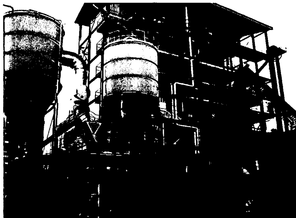
Figura 8 – Centrale BS1 – Silos di stoccaggio delle ceneri
