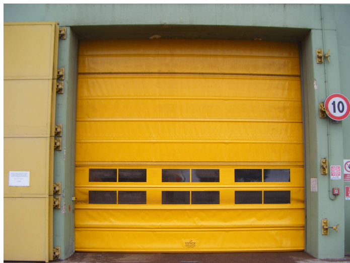
Figura 2 – Centrale BS1 – Portone di accesso al capannone di stoccaggio biomassa solida
