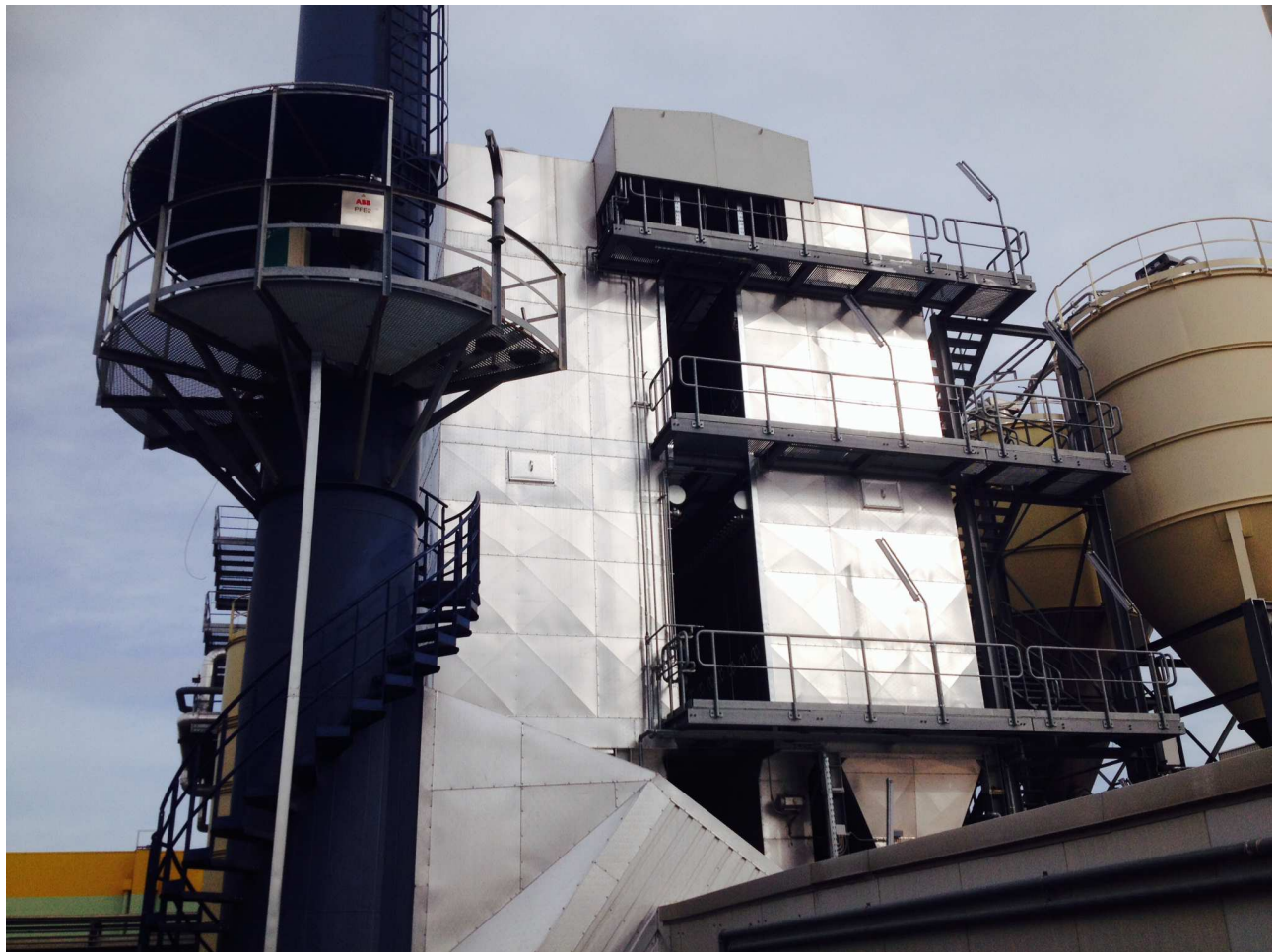
Figura 7 – Centrale BS1 - Sezioni di filtrazione a maniche
