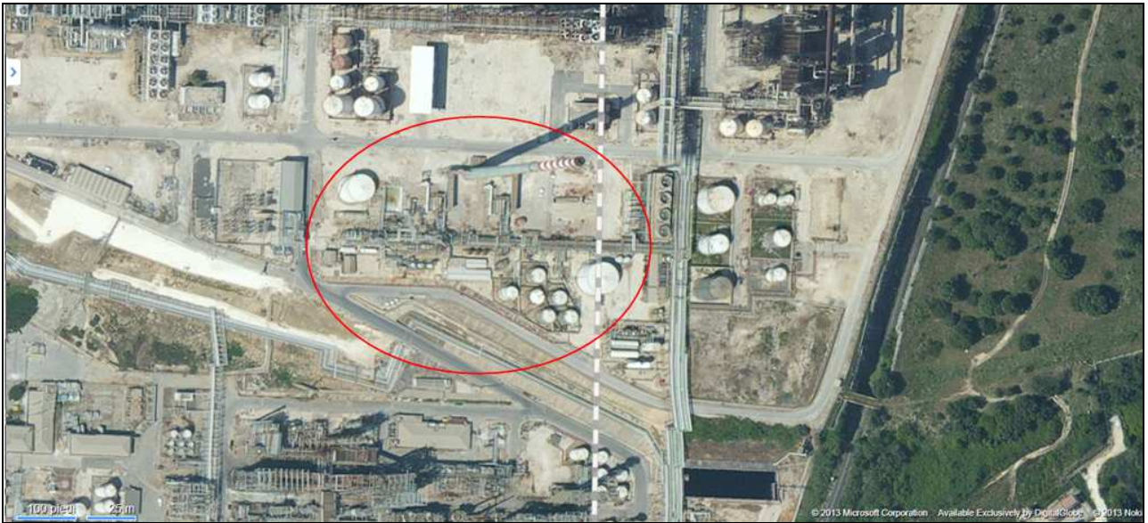
Figura 3: Aerofotogrammetria Servizi Ausiliari 2 – Sasol Italy S.p.A., Stabilimento di Augusta
