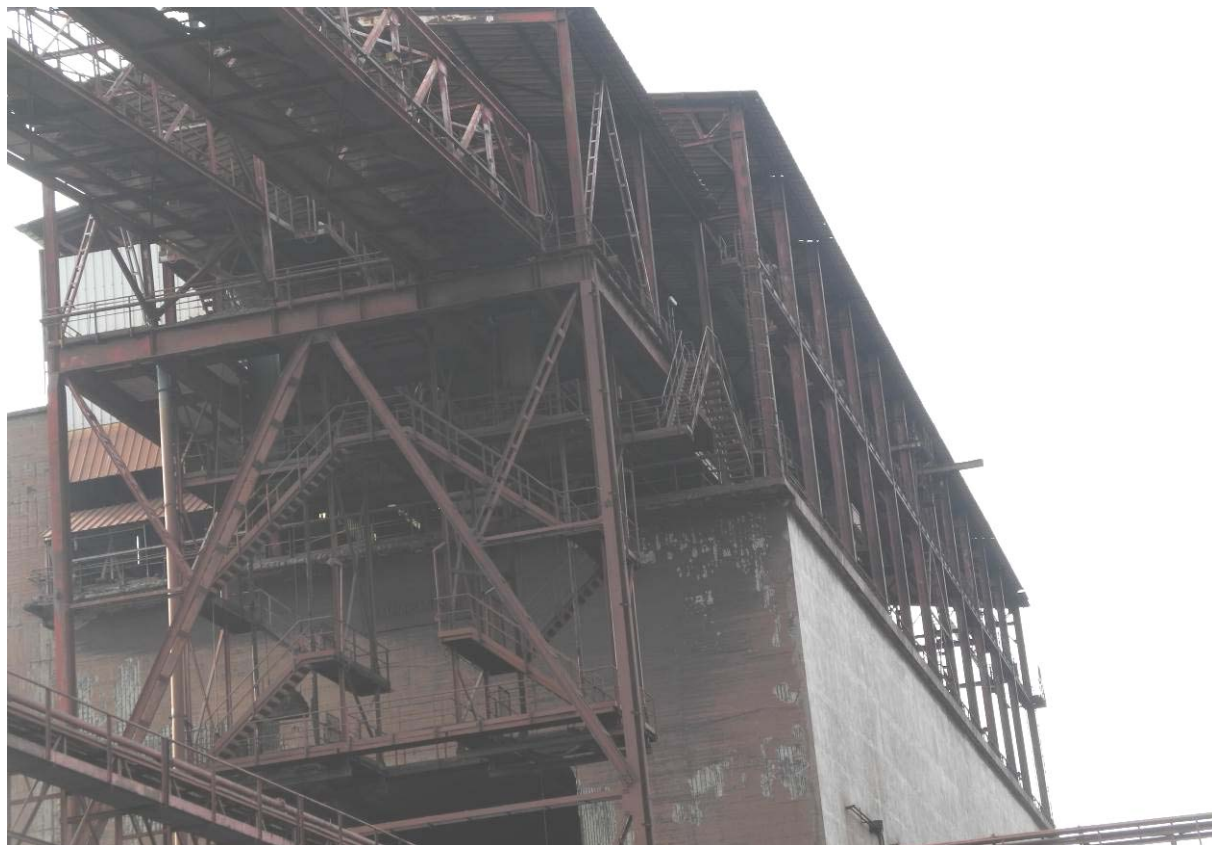
Figura 3: Vista SH lato Campiglia (vista da est).
