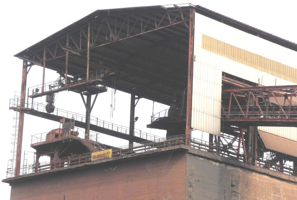
Figura 2: Vista SH lato Piombino / mare (vista da sud ovest).
