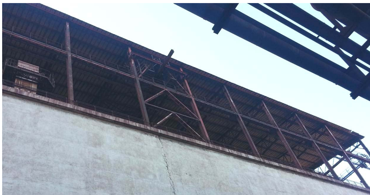
Figura 7: Particolare vista esterna piano giostre, lato monte, porzione destra.
