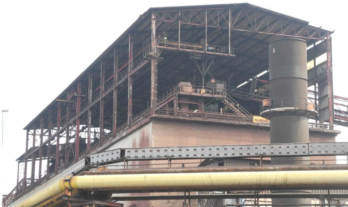
Figura 4: Vista SH lato Piombino (vista da nord ovest).
