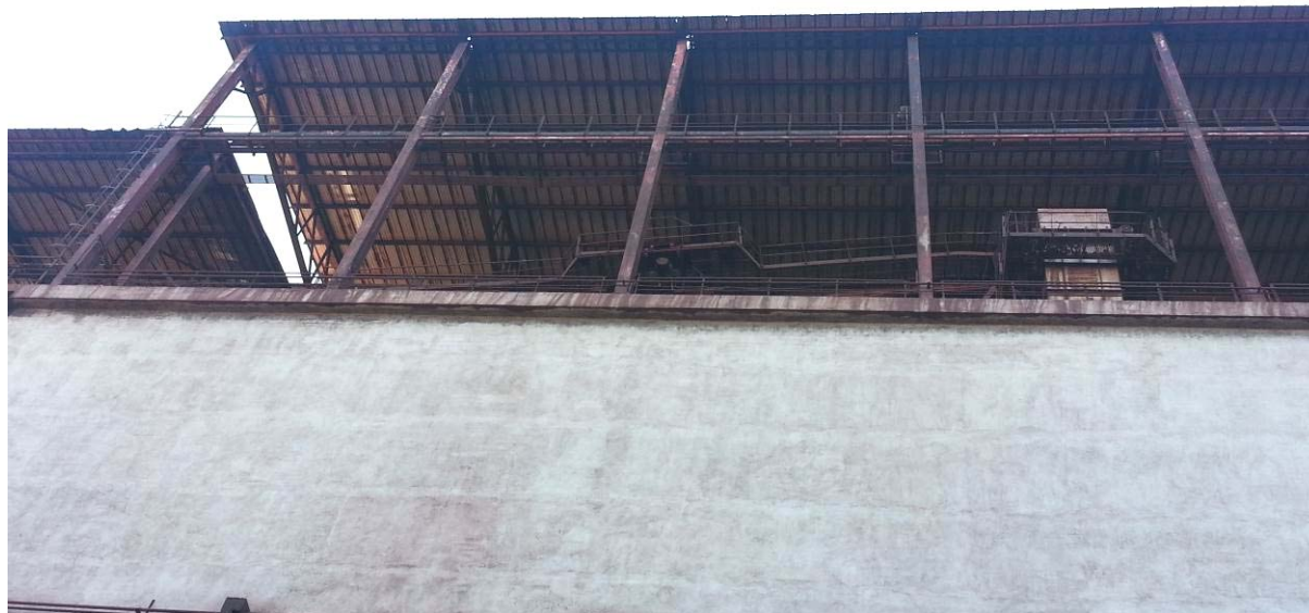
Figura 6: Particolare vista esterna piano giostre, lato monte, porzione sinistra.
