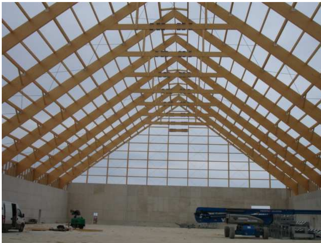
Fig. 4.1.1.3 e Esempio di copertura in legno lamellare
