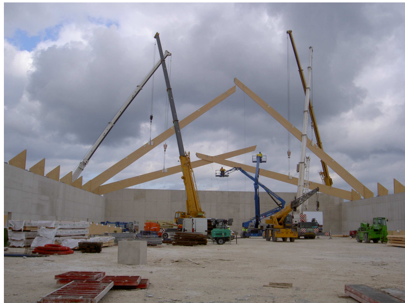
Fig. 4.1.2.3 f Esempio realizzazione di copertura in legno lamellare
