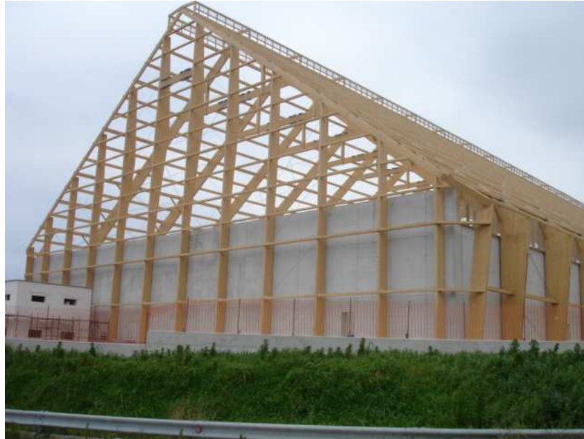
Fig. 4.1.2.3 e Esempio di copertura in legno lamellare
