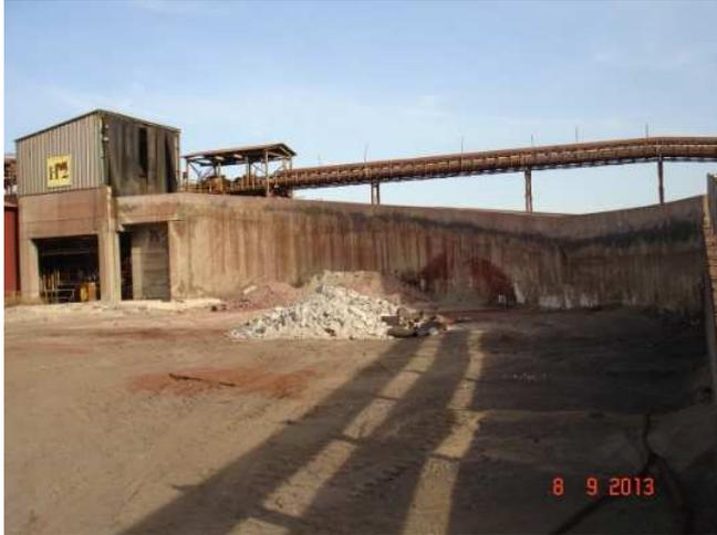
La struttura che sosterrà le tramogge di recupero sarà della stessa tipologia di quelle esistenti. Come fondazioni verranno realizzare due platee a sostegno dei quattro pilastri portanti, in sommità verrà realizzato un coronamento formato da travi per accogliere la struttura in carpenteria della tramoggia e la tettoia di copertura e protezione. La struttura sopra descritta sarà realizzata completamente in cemento armato e totalmente svincolata rispetto alla rampa di servizio.
