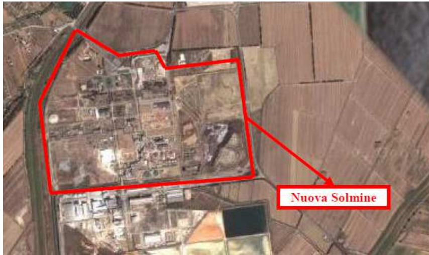
Vista aerea dello stabilimento di Nuova Solmine
