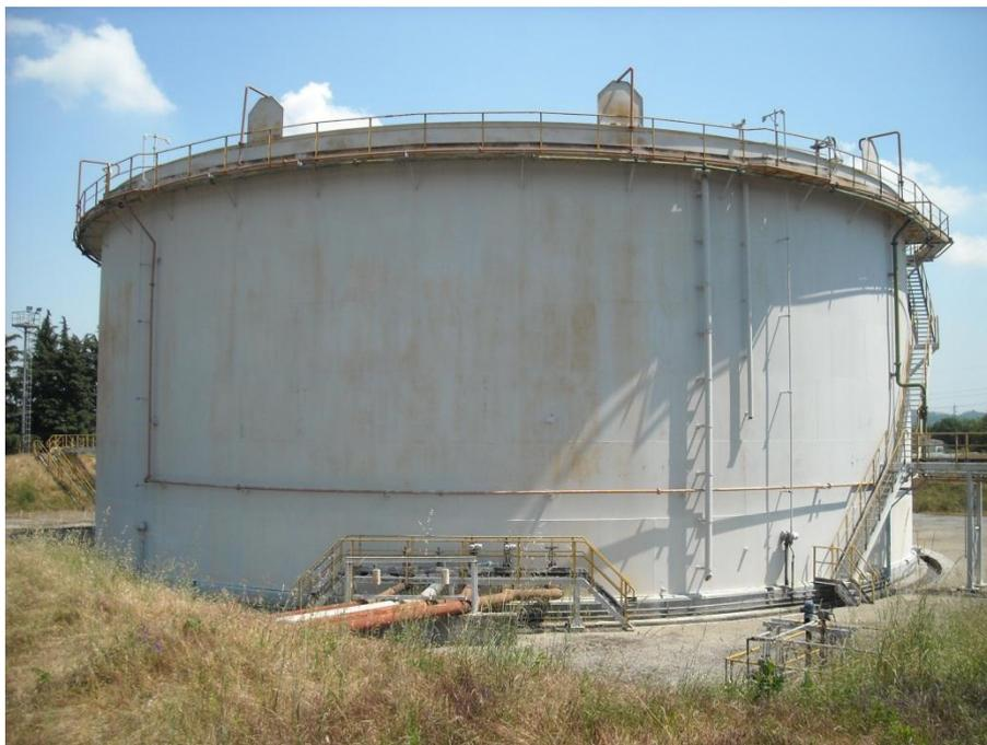
**Figura 3** - Serbatoio di stoccaggio e relativo bacino di contenimento
