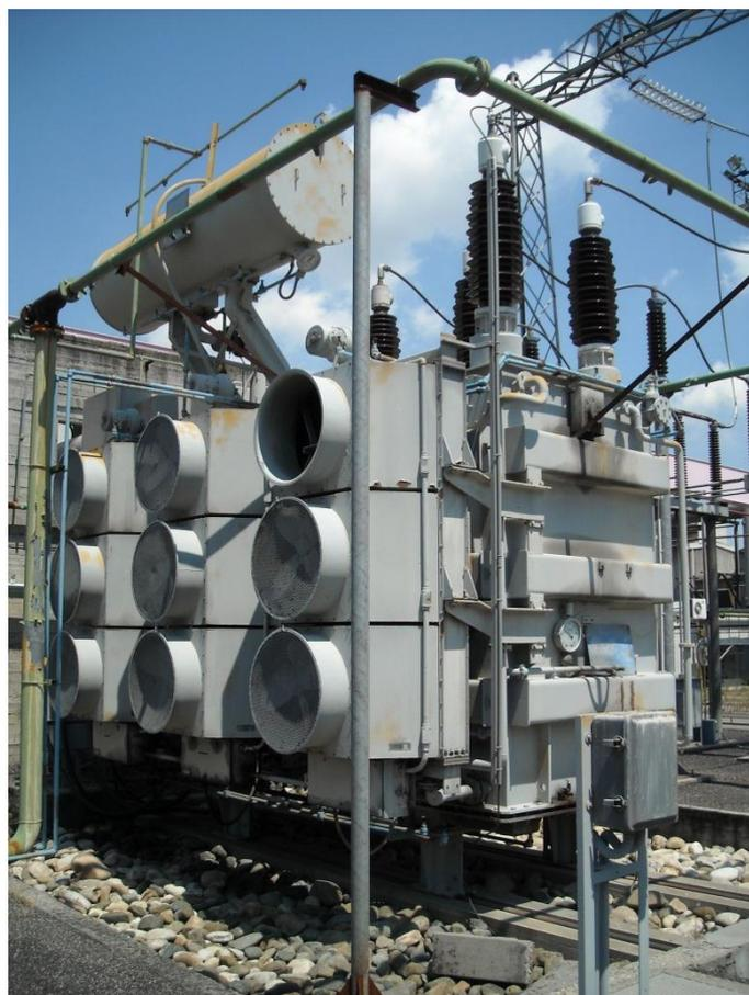
**Figura 4** – Trasformatore di potenza e relativa vasca di contenimento
