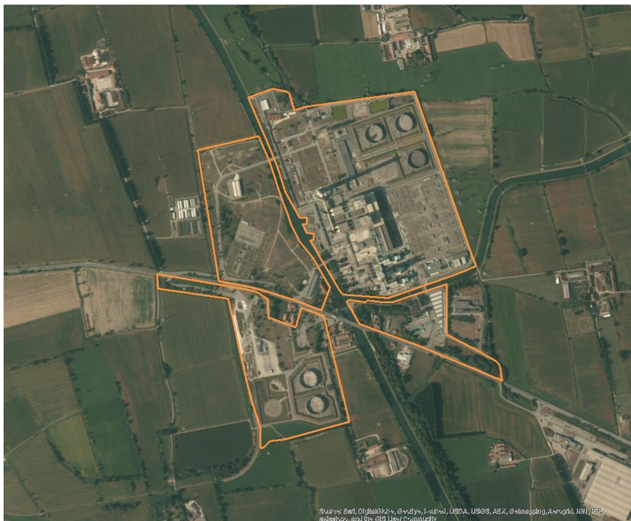
Figura 2.3 – Fotografia aerea del sito della Centrale. La via Emilia si sviluppa da Est ad Ovest, il canale Muzza da Nord a Sud
