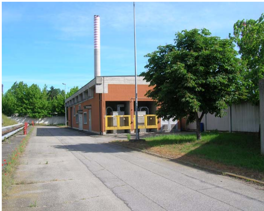
Foto 28: Area 3 Parco combustibile sud - Cabina schiumogeni
