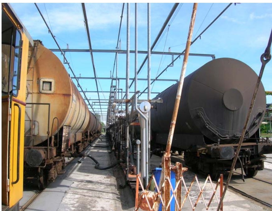
Foto 34: Area 4 Stazione di scarico o.c.- Ferrocisterna particolare 2
