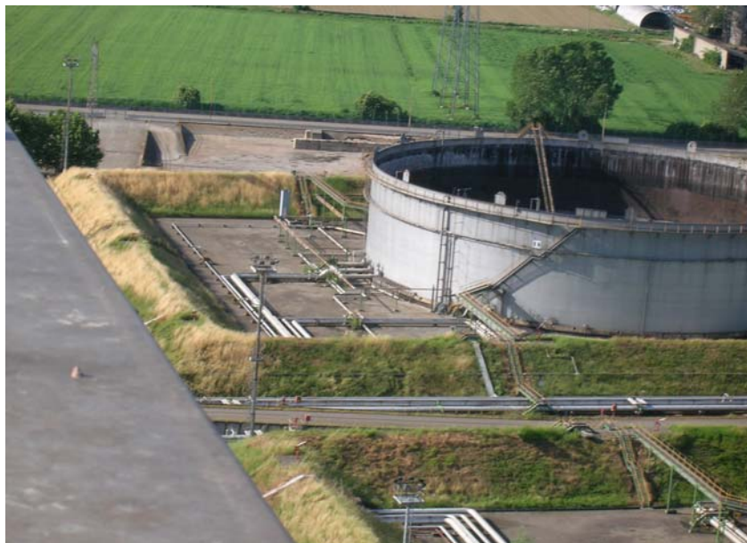
Foto 14: Area 2 Parco combustibile nord - Particolare tetto galleggiante danneggiato Serbatoio N°1
