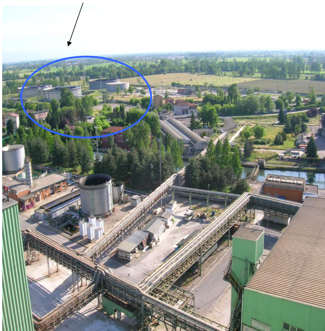
Foto 21: Area 3 Parco combustibile sud
