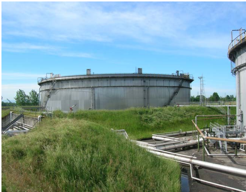
Foto 23: Area 3 Parco combustibile sud – Particolare serbatoio N°6 coibentato
