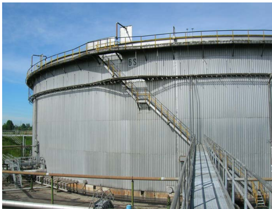
Foto 23: Area 3 Parco combustibile sud – Particolare serbatoio N°6 coibentato
