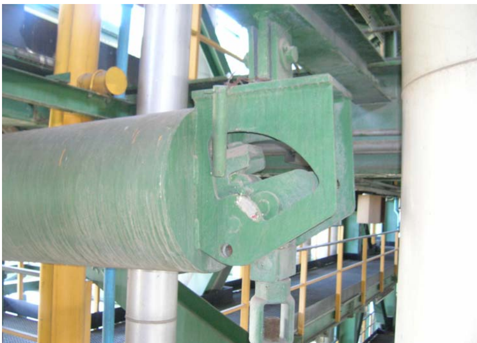
Foto 3: Area 1 Caldaia GR.8 - Particolare giunto struttura portante
