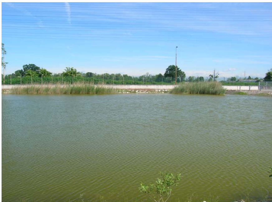
Foto 19: Area 2 Parco combustibile nord - Particolare vasca di accumulo cenere
