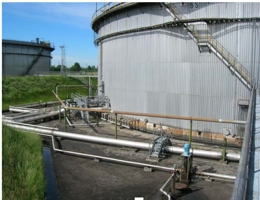
Foto 24: Area 3 Parco combustibile sud – Particolare serbatoio N°6 piping alla base
