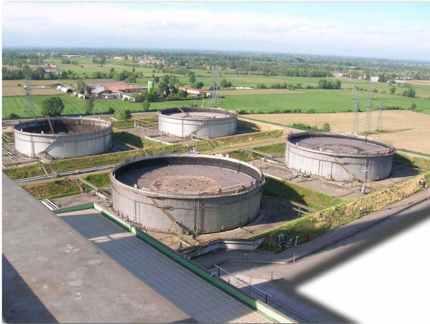
TAVOLA 1 - INTERVENTI DI REINSERIMENTO PAESAGGISTICO - Foto Parco combustibili Nord prima degli interventi
