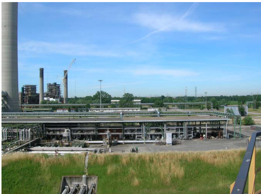
Foto 15: Area 2 Parco combustibile nord - Stazione pompaggio combustibile GR.7-8
