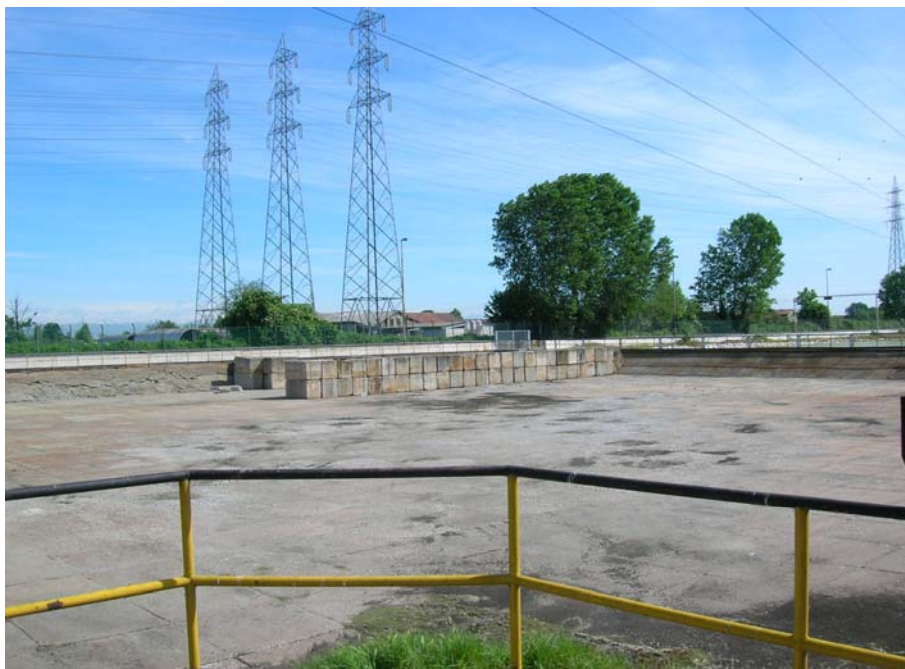
Foto 20: Area 2 Parco combustibile nord - Particolare vasca di accumulo fanghi
