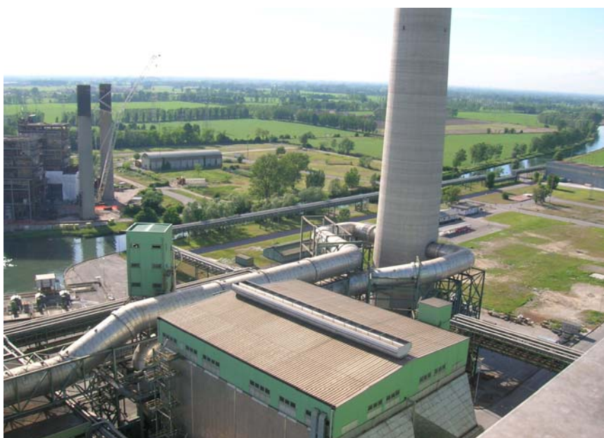
Foto 10: Area 1 GR 7-8 – Sistema di adduzione fumi alla ciminiera particolare 2
