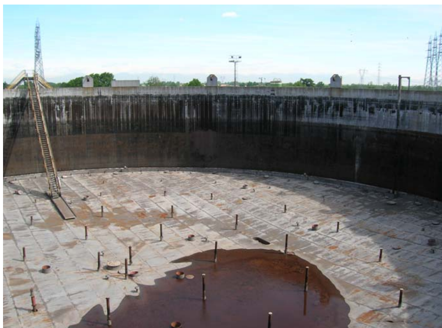
Foto 14: Area 2 Parco combustibile nord - Particolare tetto galleggiante danneggiato Serbatoio N°1
