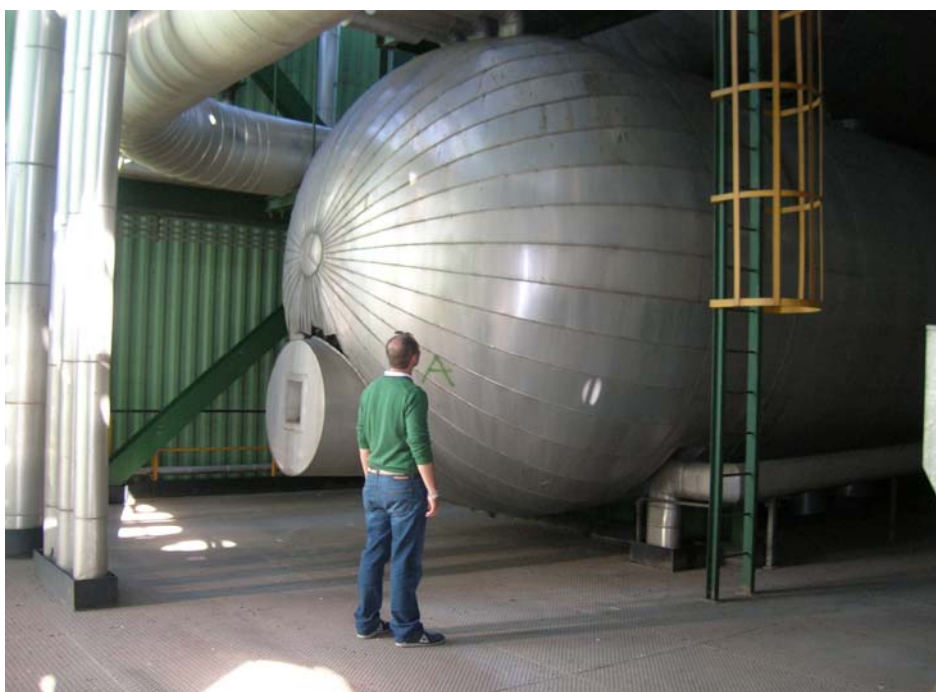
Foto 7: Area 1 Caldaia GR8 - Degasatore particolare
