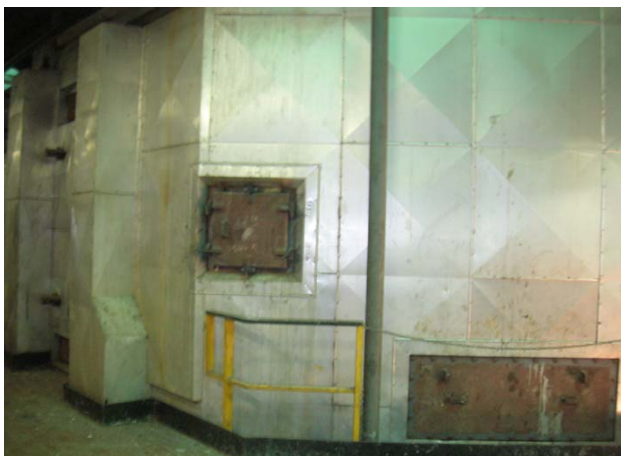
Foto 5: Area1 Caldaia GR8 - Riscaldatori aria Lyungstroem particolare 2
