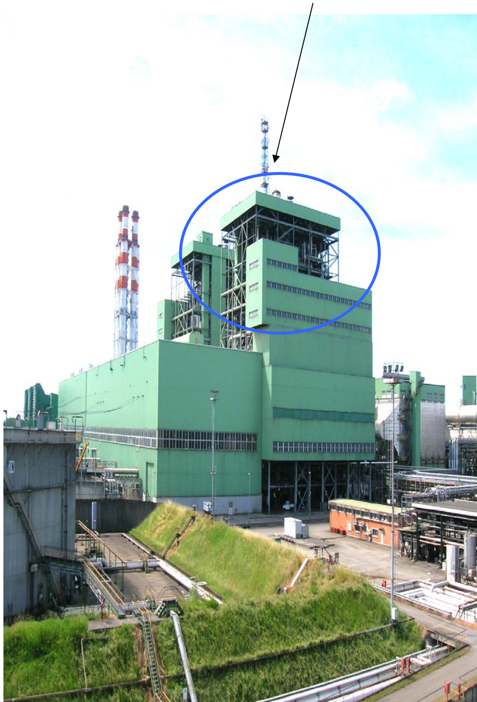
Foto n°1 : Area 1 - Edifici caldaie GR 7 e GR8
