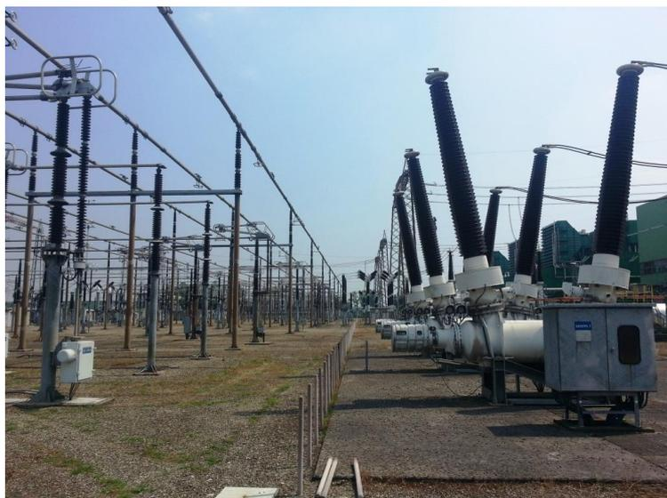
Fotografia 5 - Vista interruttore di macchina gr.7 - tolto il conduttore
