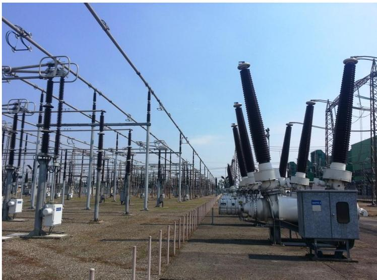
Fotografia 6 - Vista interruttore di macchina gr.8 - tolto il conduttore
