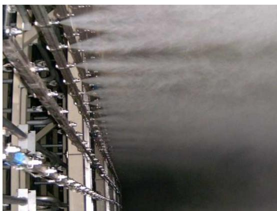
Figura 3 Sistema di ugelli all'interno del condotto di aspirazione
