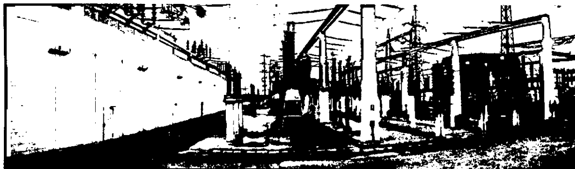
Figura 9: trasformatori principali e stazione elettrica
