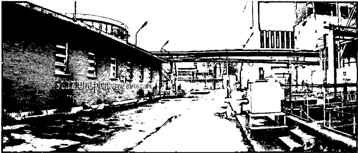
Figura 5: edificio della stazione di pompaggio e pipe-rack
