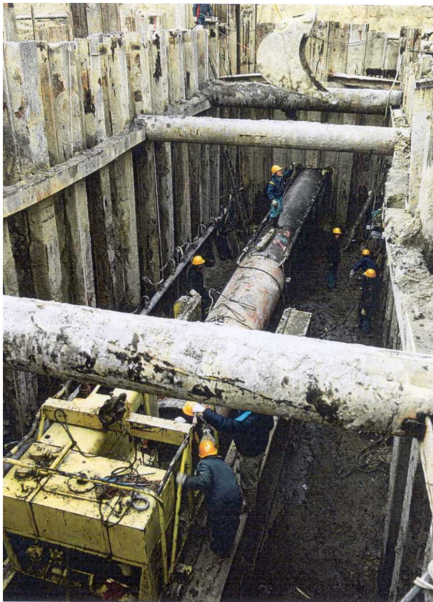
Foto 5.1/L: Trivellazione con spingitubo
