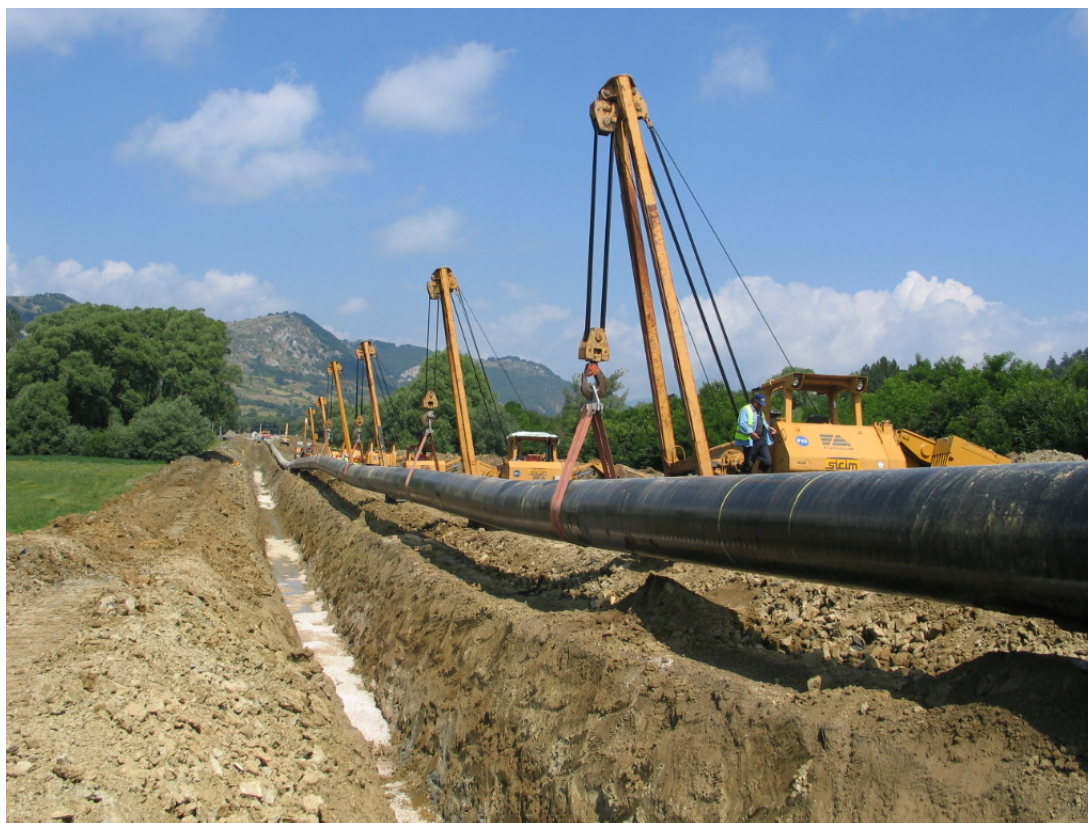
Fig. 5.1/F Posa della condotta
