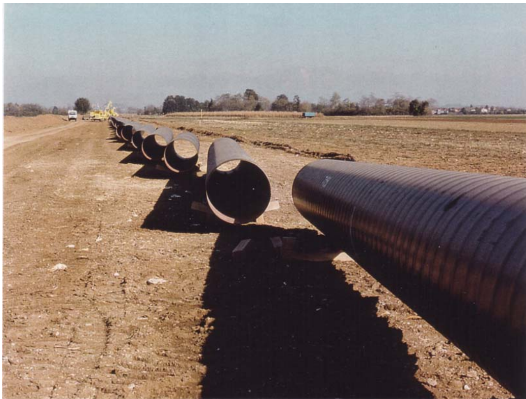
Fig. 5.1/C Sfilamento tubazioni
