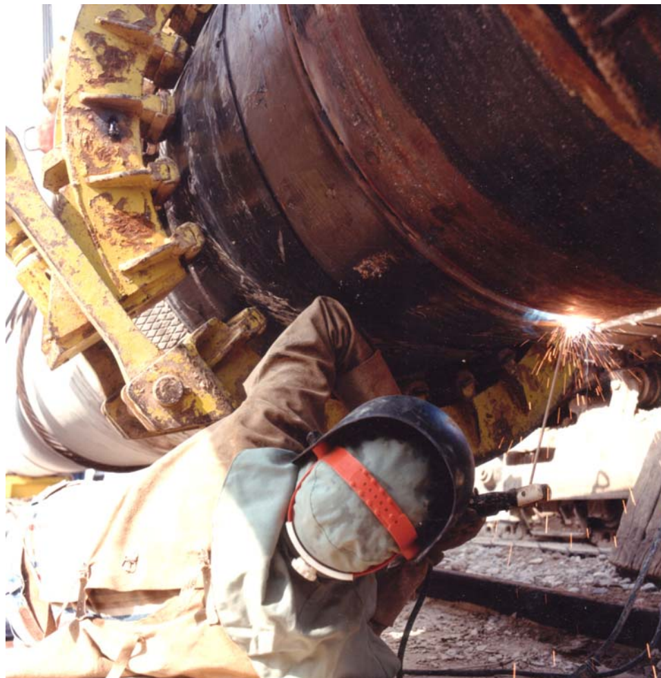
Fig. 5.1/D Saldatura di linea
