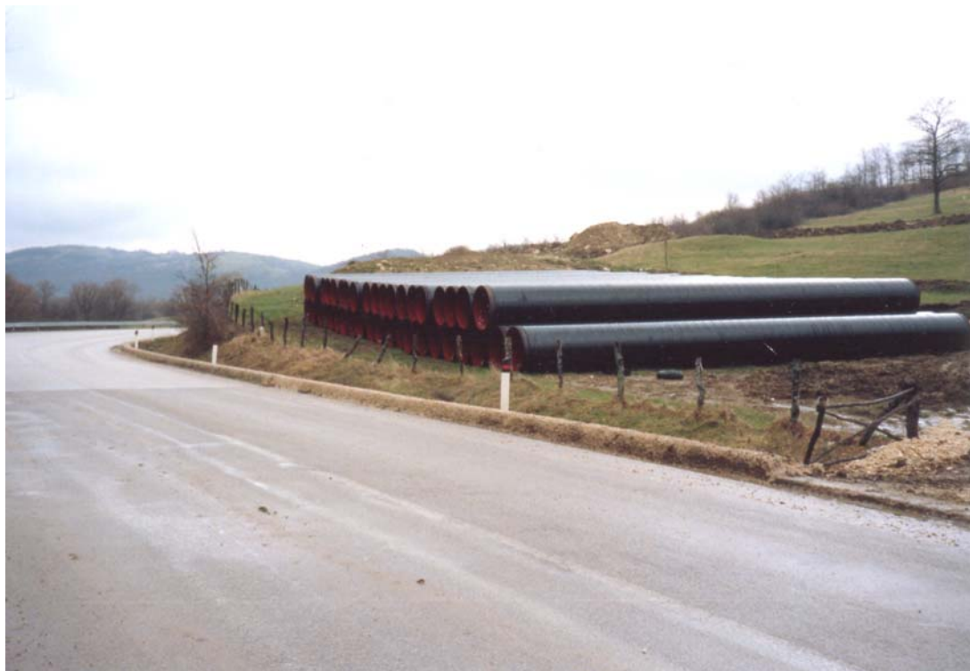
Fig. 5.1/A Piazzola di accatastamento tubazioni
