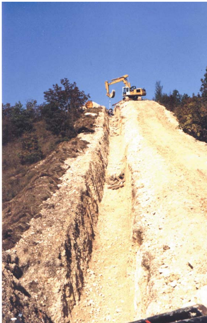
Fig. 5.1/E Scavo della trincea
