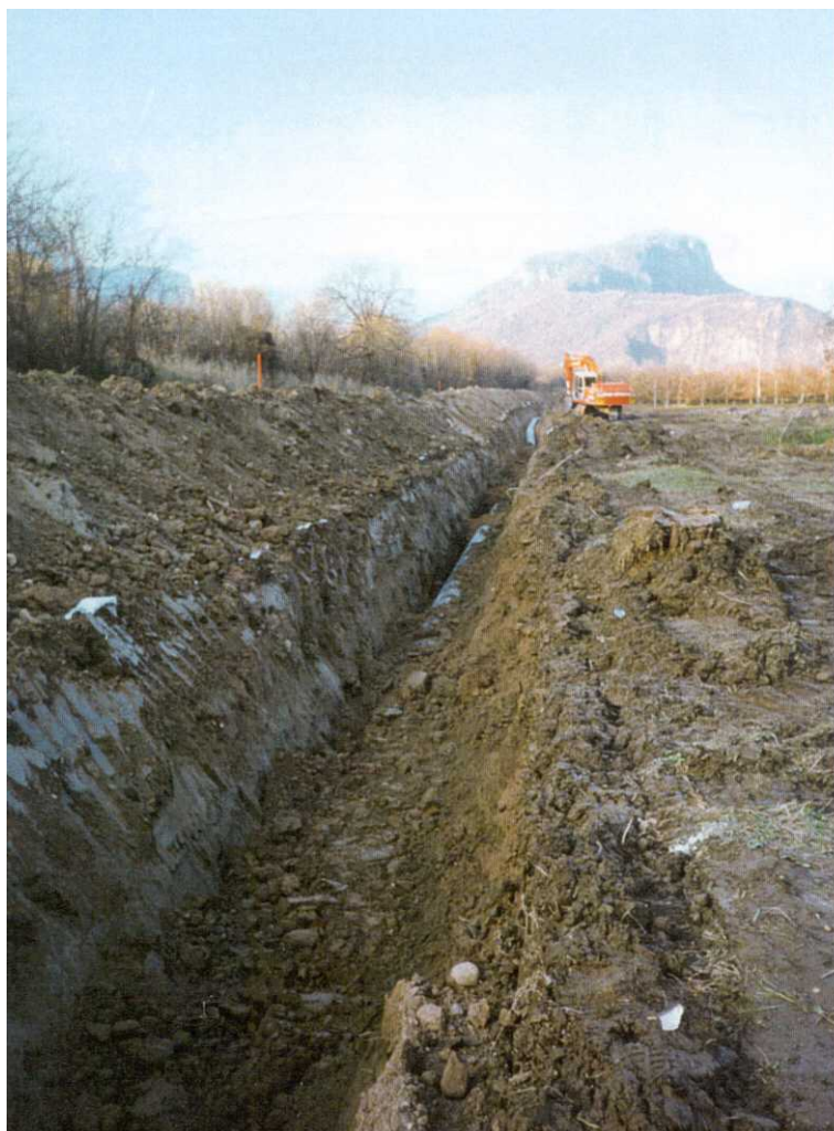
Fig. 5.1/H Rinterro della condotta
