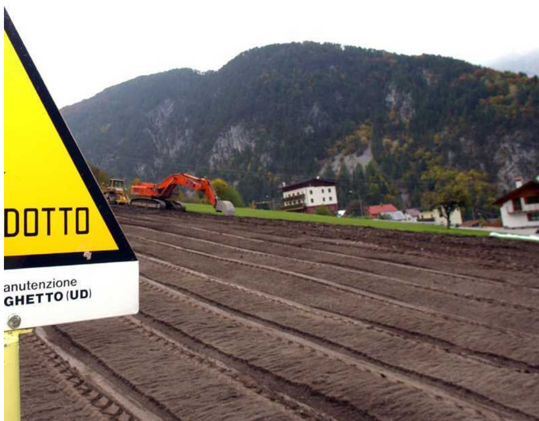
Fig. 5.1/I: Ridistribuzione dello strato humico superficiale
