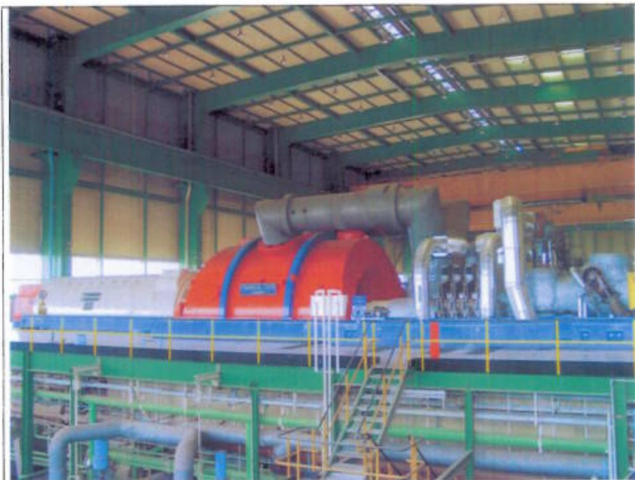
**FIG. 3** Turbina a vapore e alternatore
