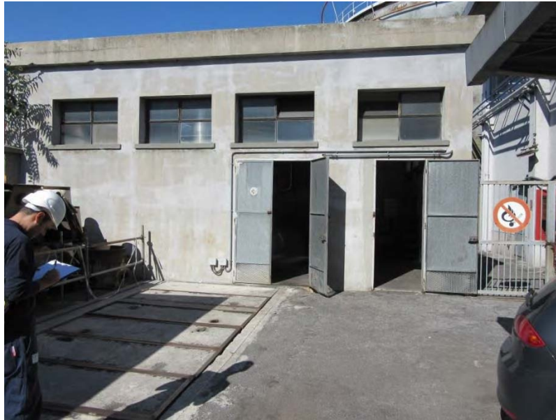
Figura 3: locale pompe di travaso
