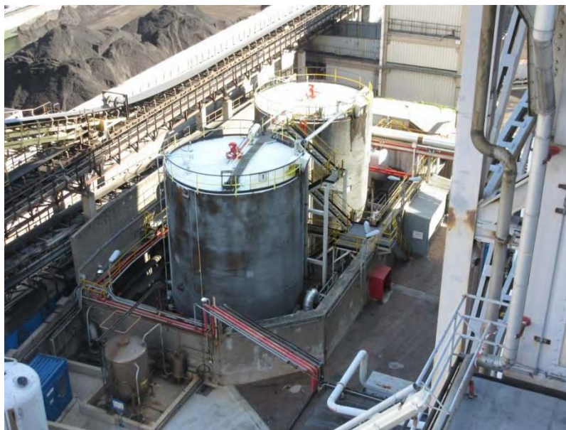
Figura 4: serbatoi di servizio con relativo bacino di contenimento
