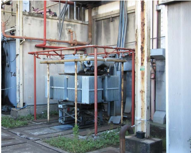
Figura 11: trasformatore all'aperto
