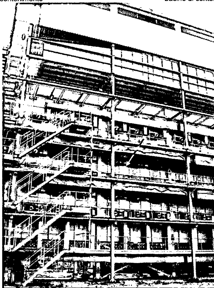
Impianto Reformer contenente il catalizzatore R-67-H
