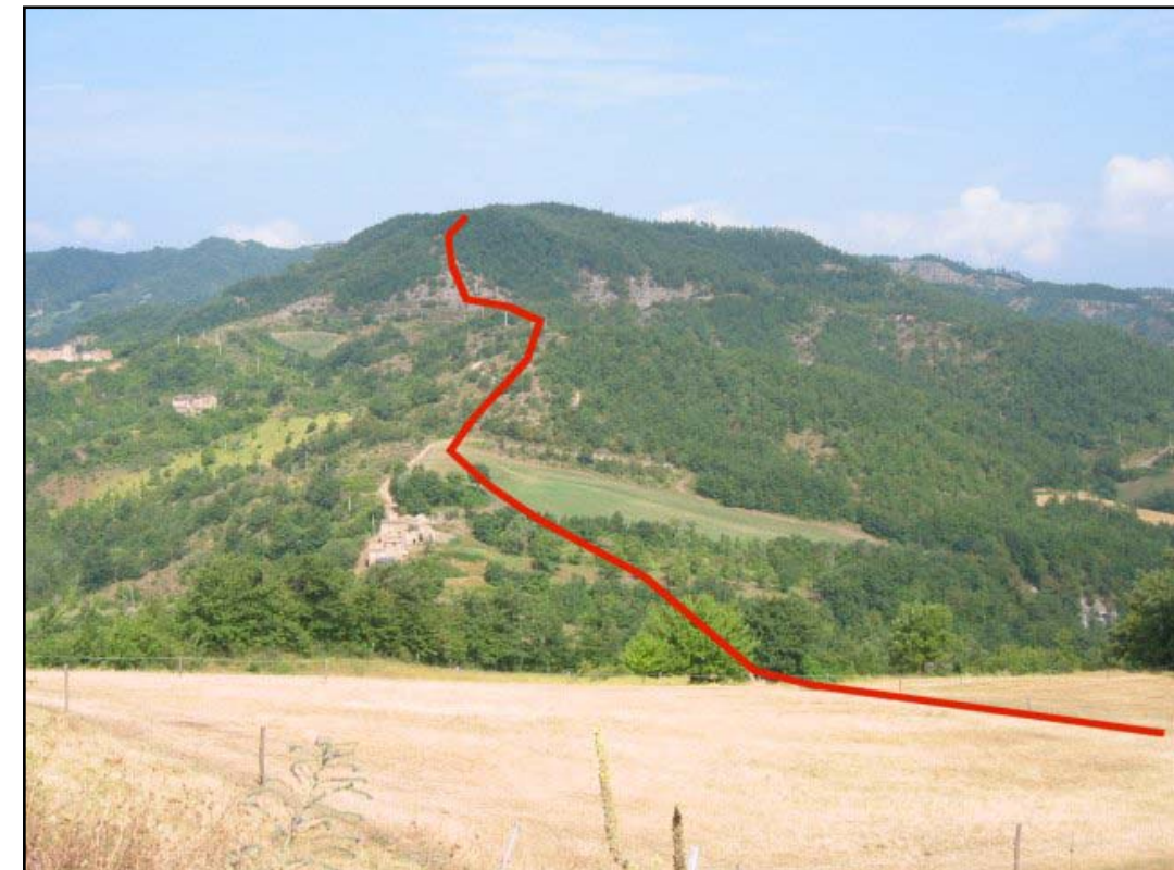
Foto 88: Risalita versante sinistro torrente Candigliano
