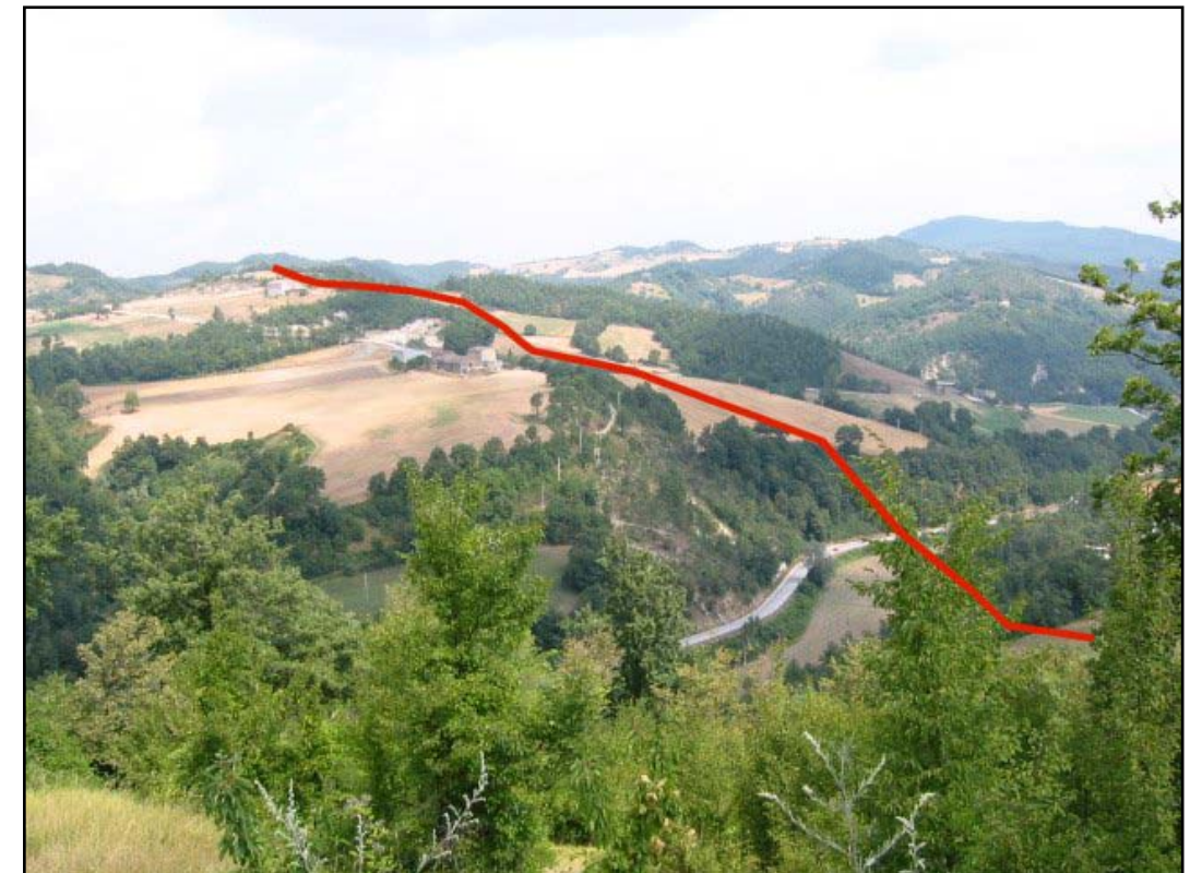
Foto 80: Panoramica risalita Versante sinistro torrente Biscubio
