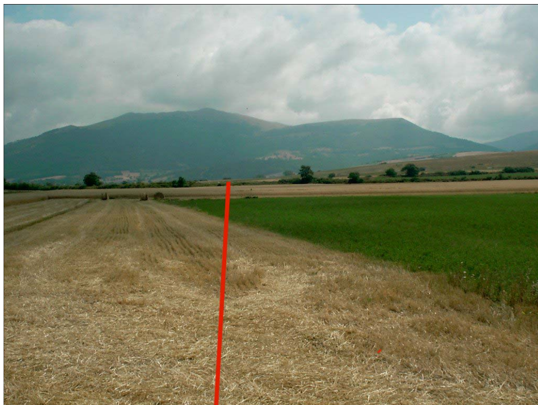
Foto 1: Vista impianto di stacco e tratto attraversamento piana di Colfiorito
