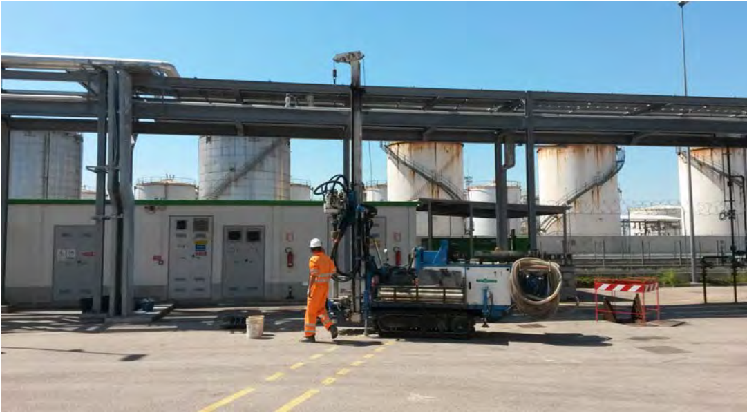
Una panoramica durante la realizzazione del sondaggio S7
