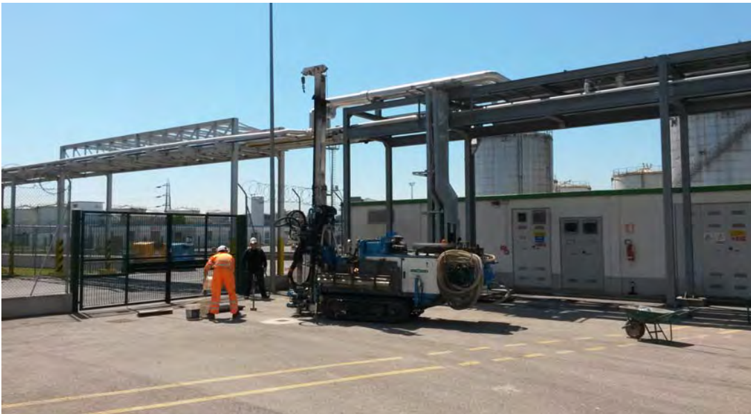
Una panoramica durante la realizzazione del sondaggio S3
