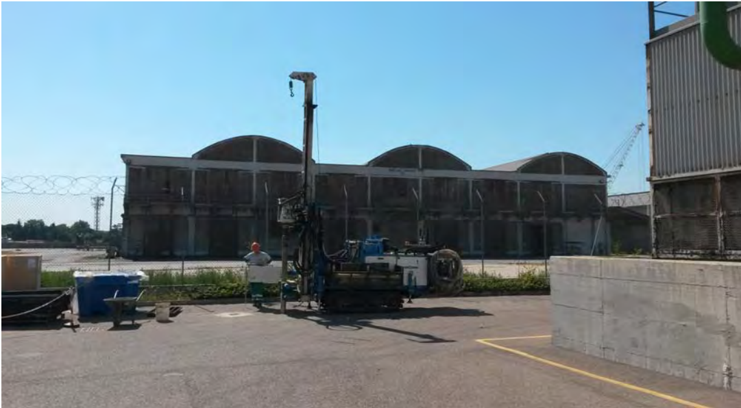
Una panoramica durante la realizzazione del sondaggio S1
