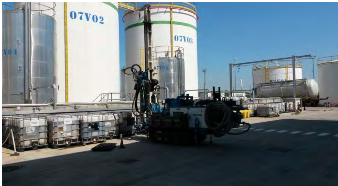
Una panoramica durante la realizzazione del sondaggio S9
