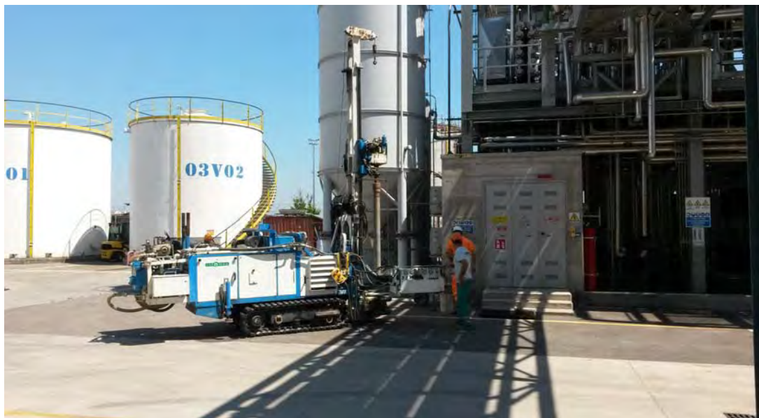
Una panoramica durante la realizzazione del sondaggio S5
