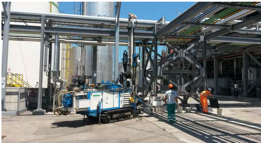
Una panoramica durante la realizzazione del sondaggio S6
