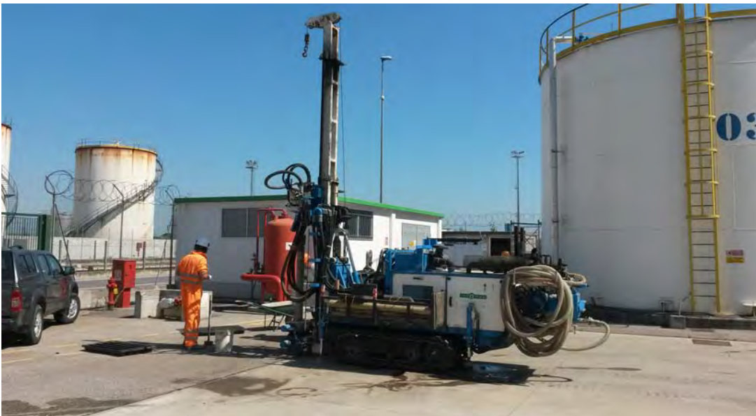
Una panoramica durante la realizzazione del sondaggio S4
