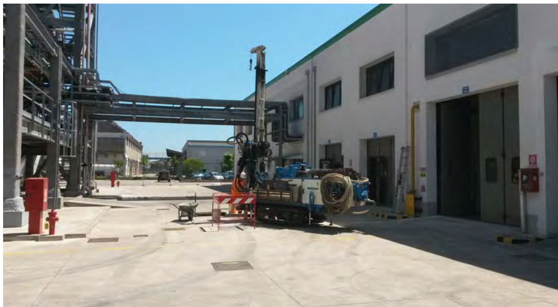
Una panoramica durante la realizzazione del sondaggio S10
