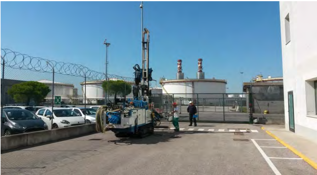
Una panoramica durante la realizzazione del sondaggio S8
