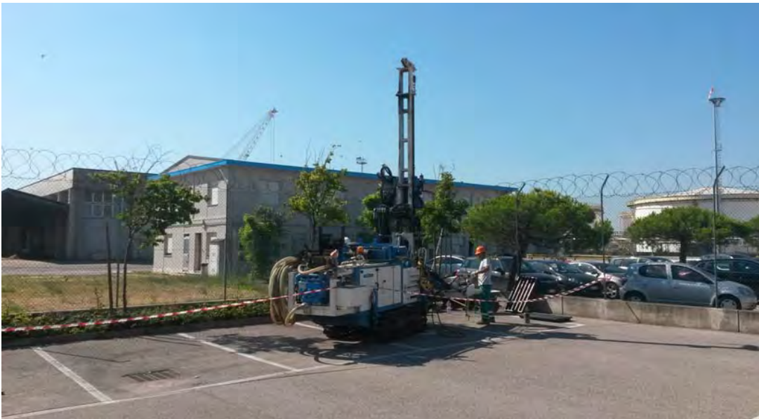
Una panoramica durante la realizzazione del sondaggio S2
