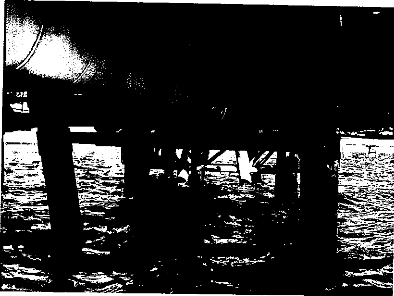
Fig. 8: tubazioni in corrispondenza alla piattaforma intersezione.
