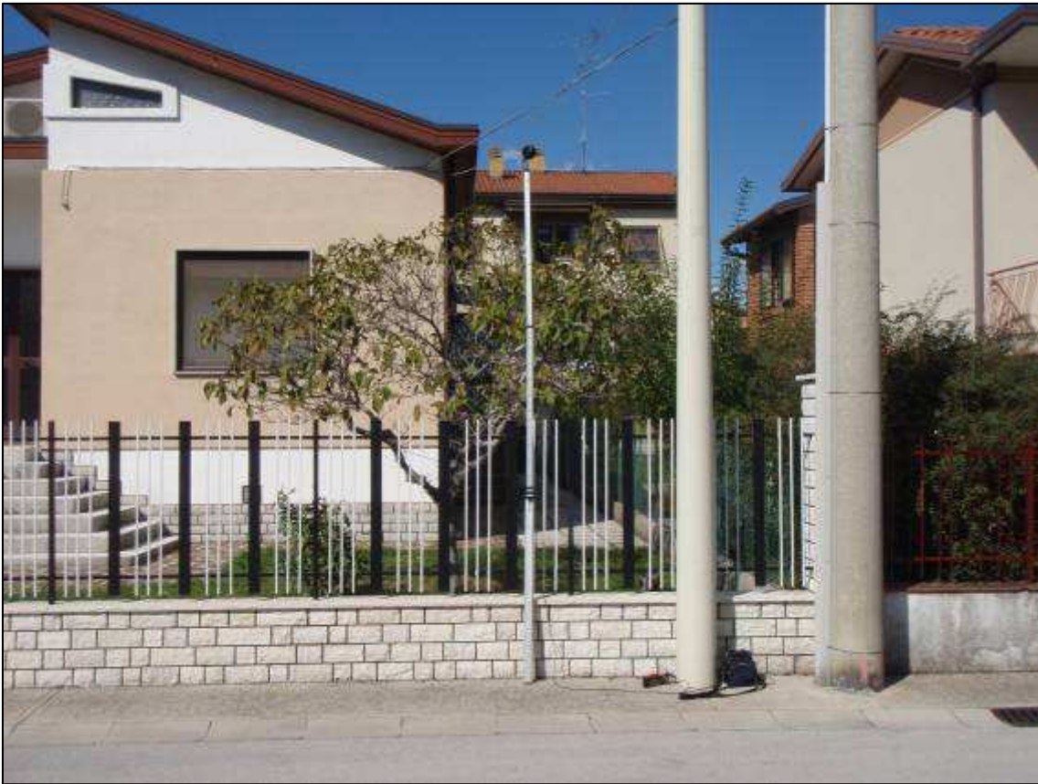
Fotografia punto di misura
