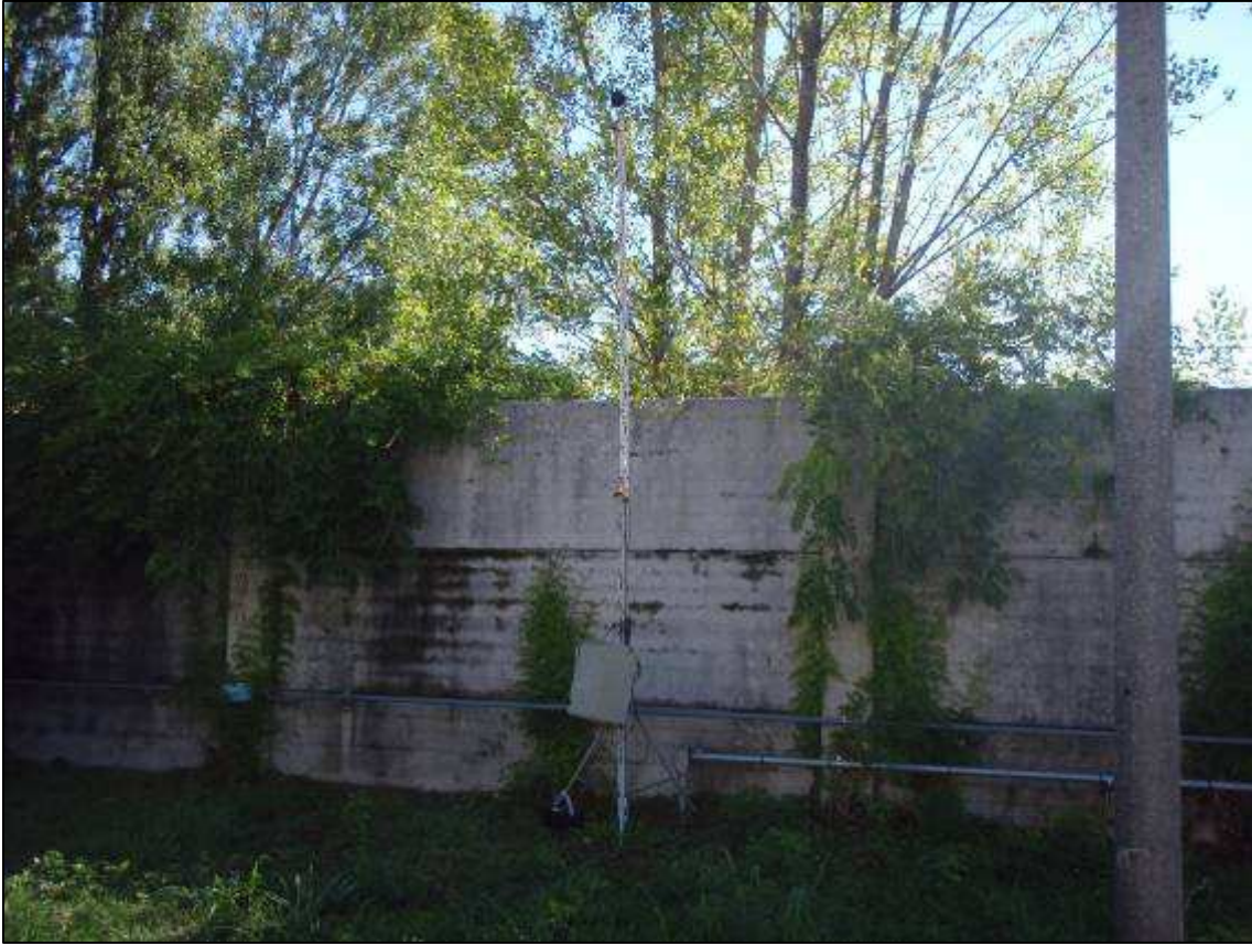
Fotografia punto di misura
