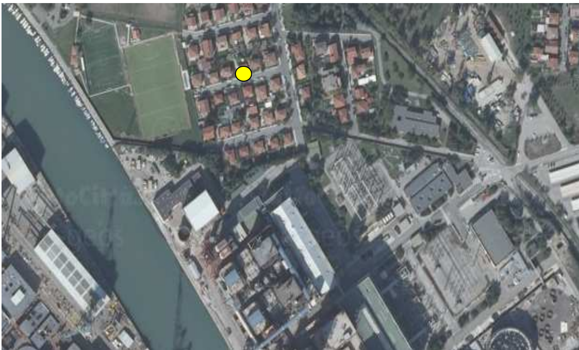
Vista aerea punto di misura
