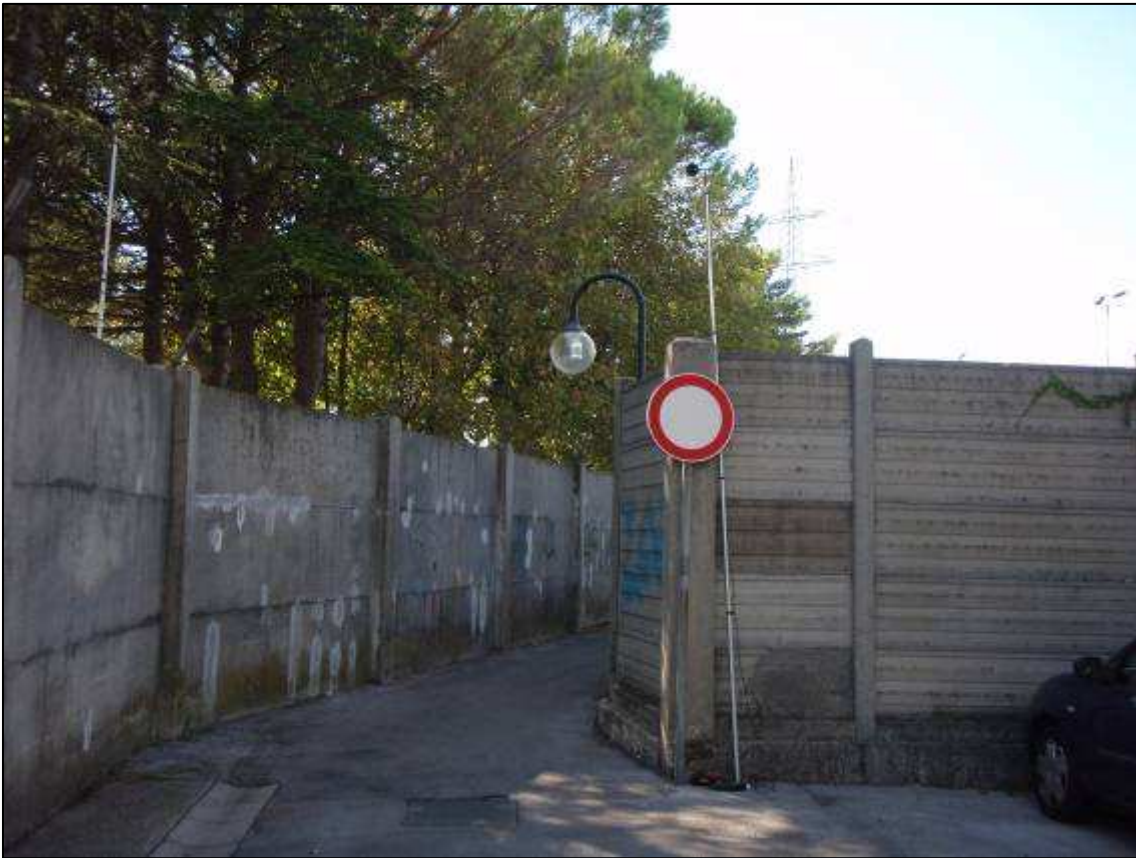
Fotografia punto di misura
