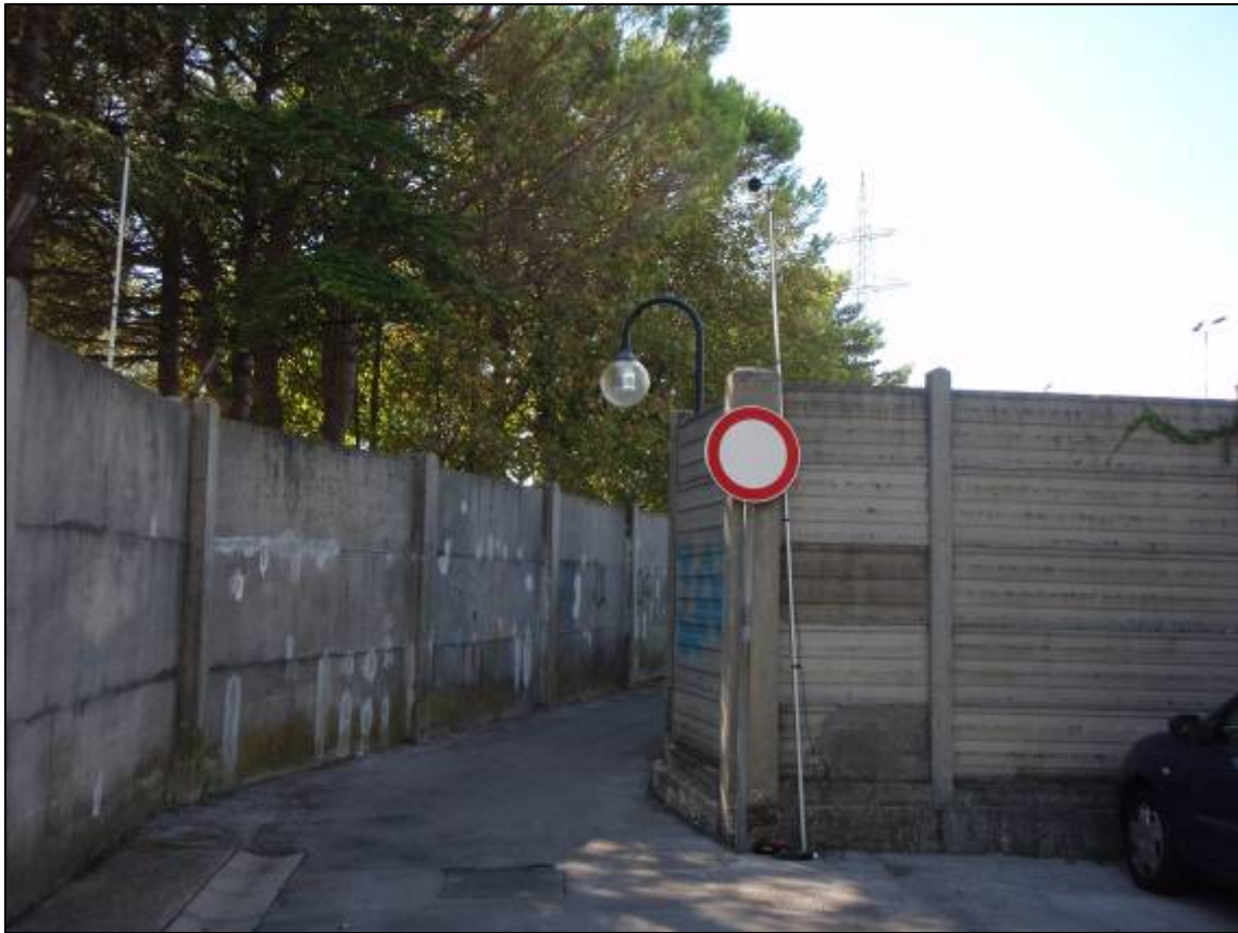
Fotografia punto di misura
