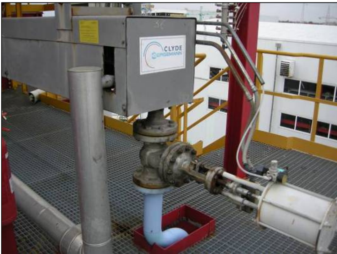
Figura 8: vista sistema di movimentazione soffiatori
