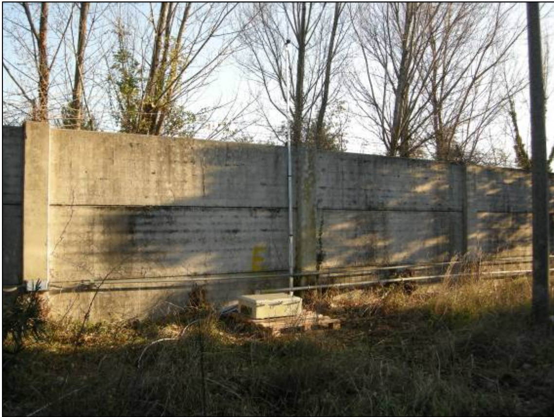
Fotografia punto di misura
