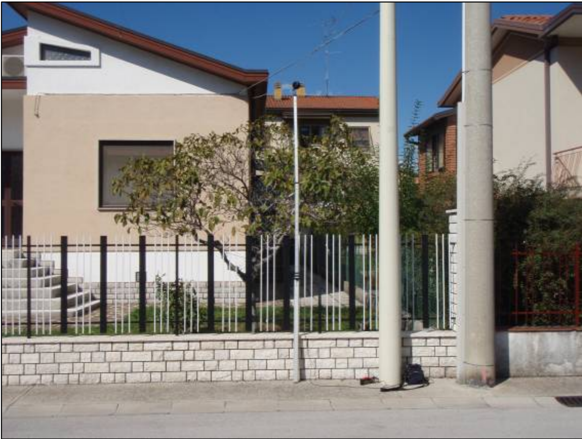
Fotografia punto di misura
