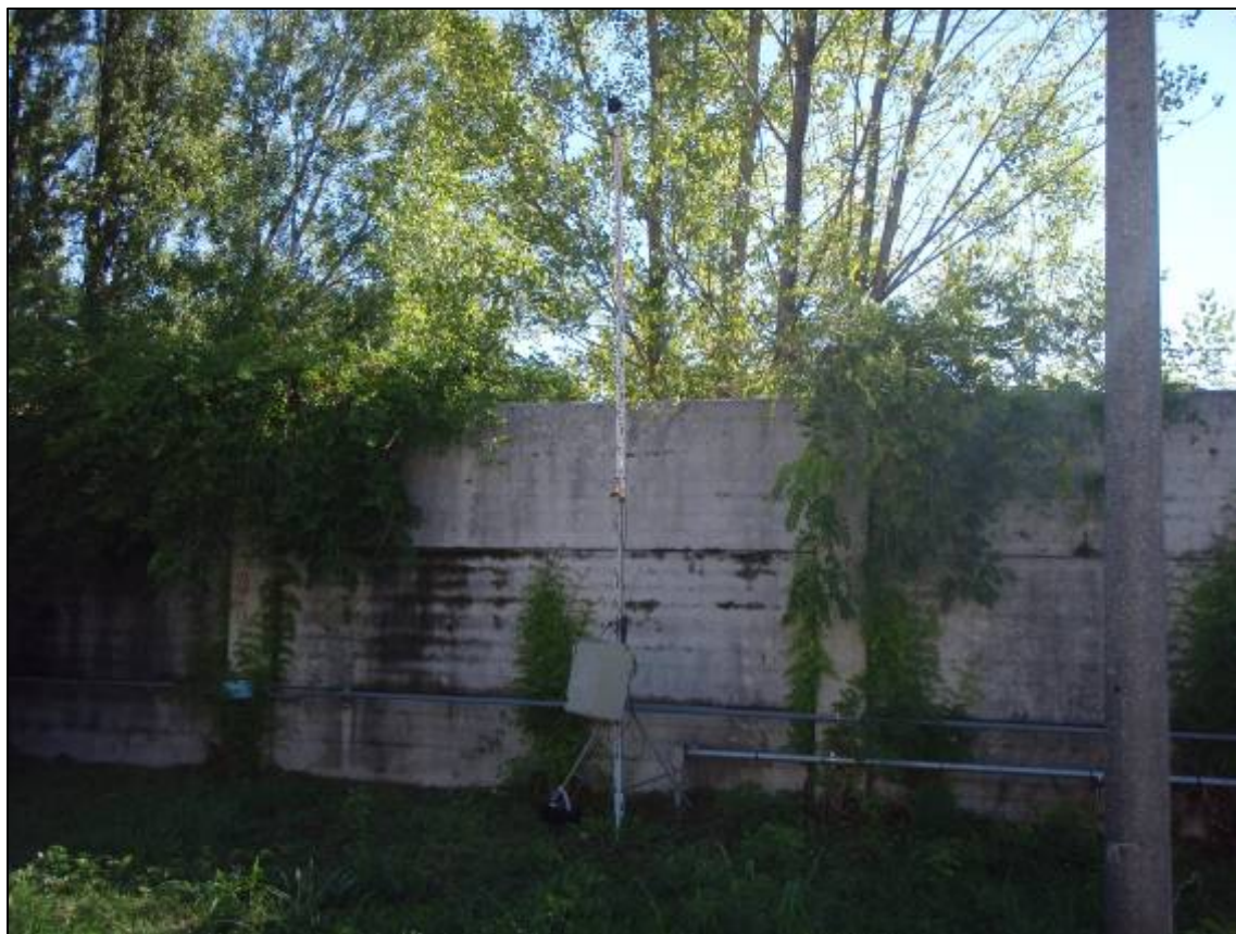
Fotografia punto di misura
