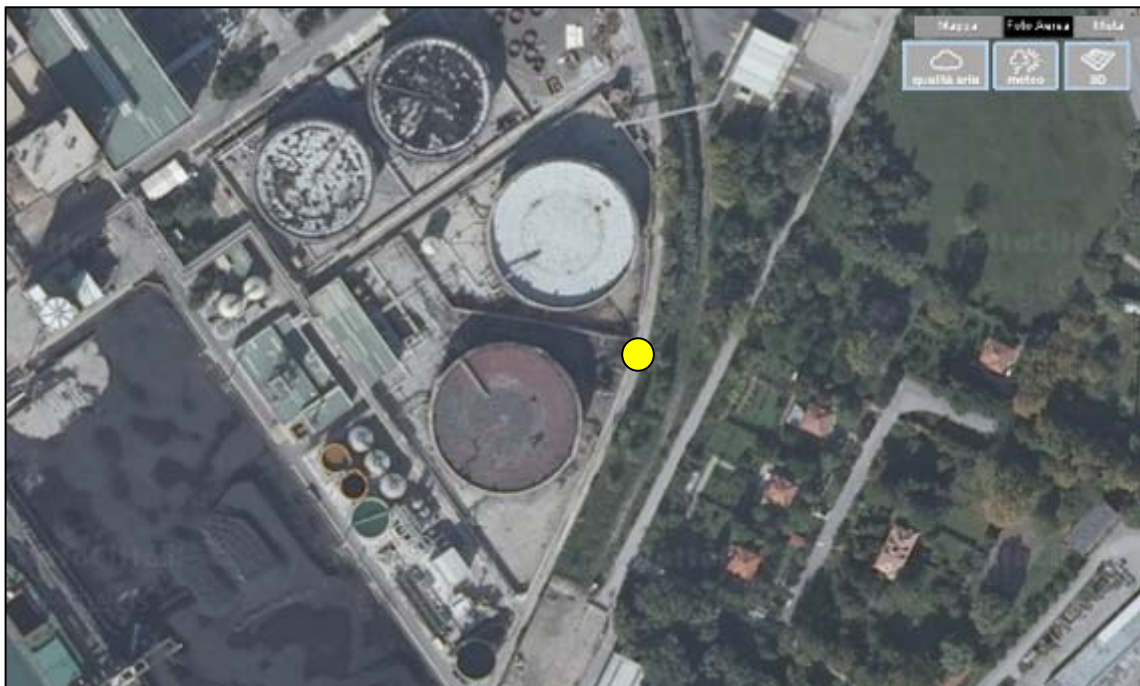
Vista aerea punto di misura
