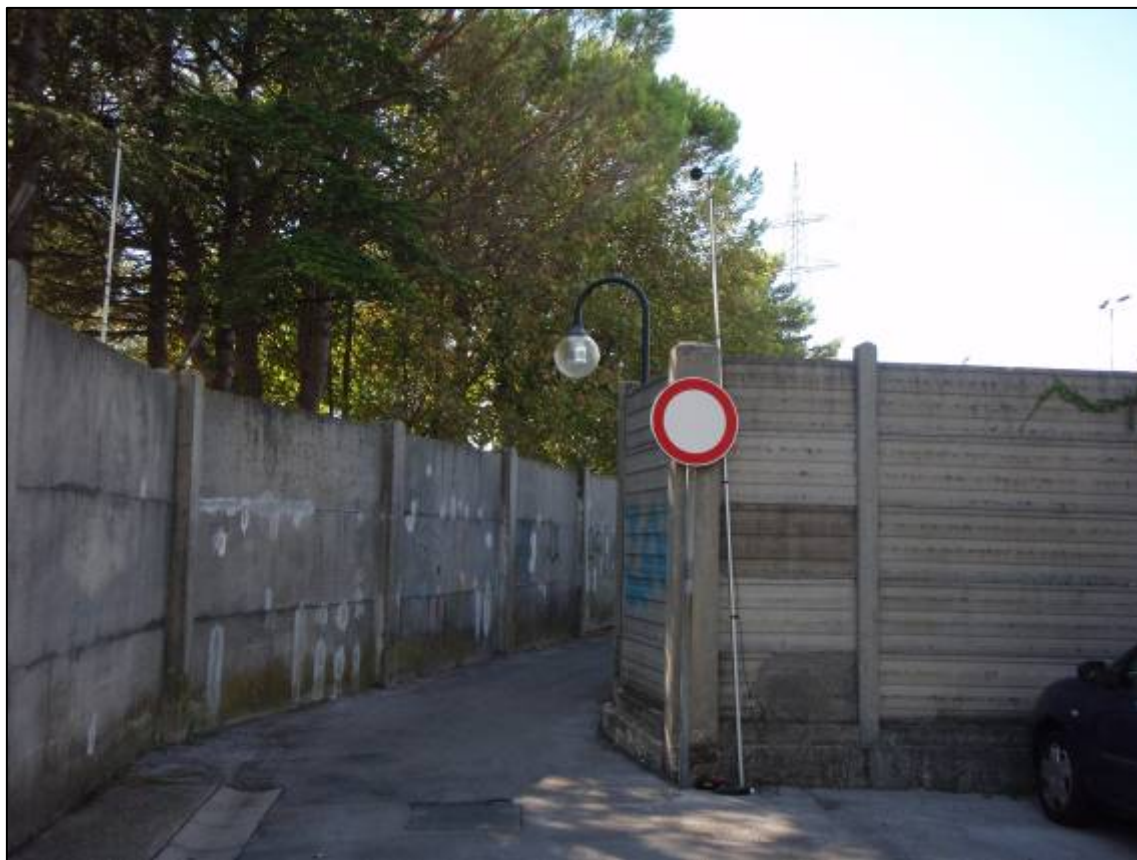
Fotografia punto di misura
