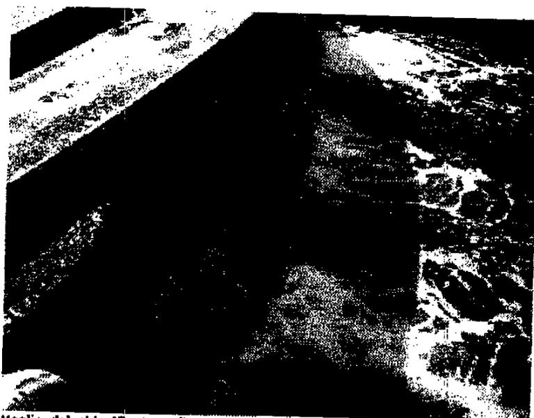
**Figura 21 -** Dettaglio del chiarificatore. Il controllo dello scarico SF1 avviene tramite prelievo dall'anello circolare prima del deflusso nella vasca di raccolta finale.
