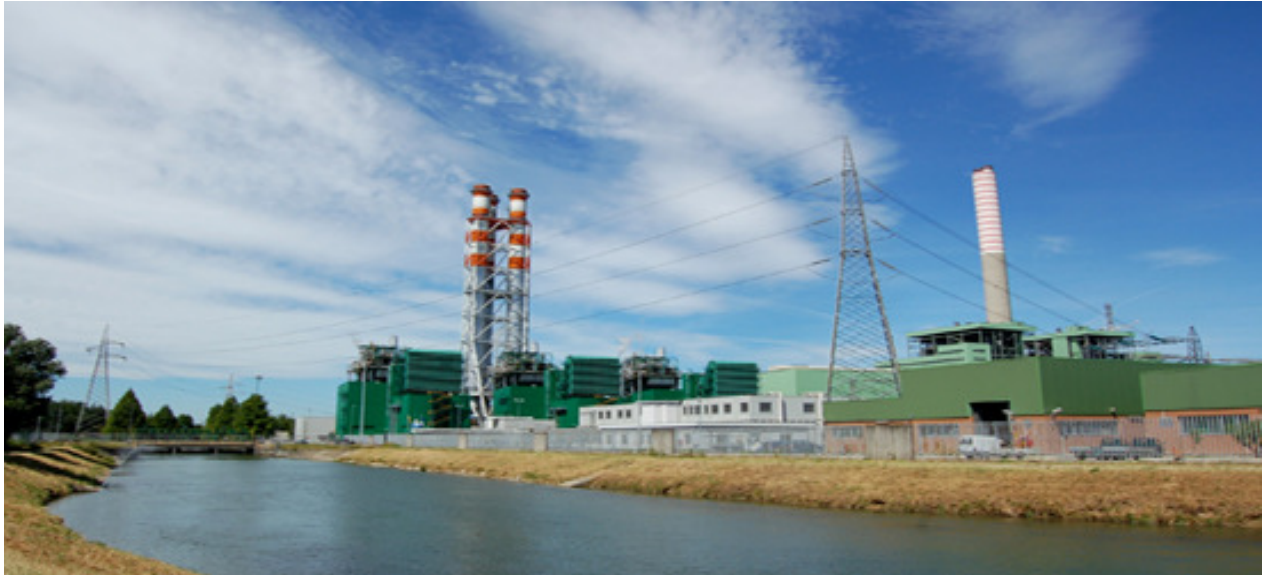
Figura: l'impianto di Tavazzano - Montanaso
