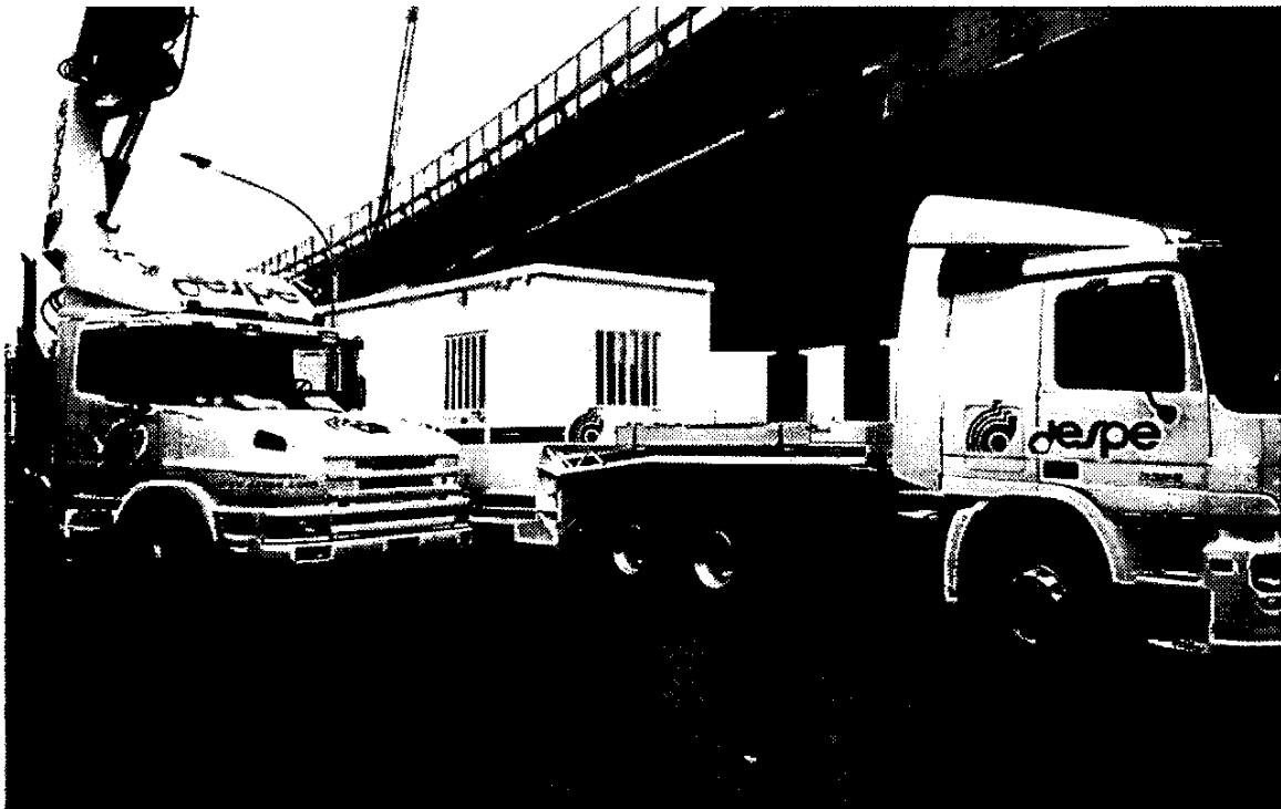
Attività logistiche e accantieramento, 3-5-2010 ÷ 4-6-2010
